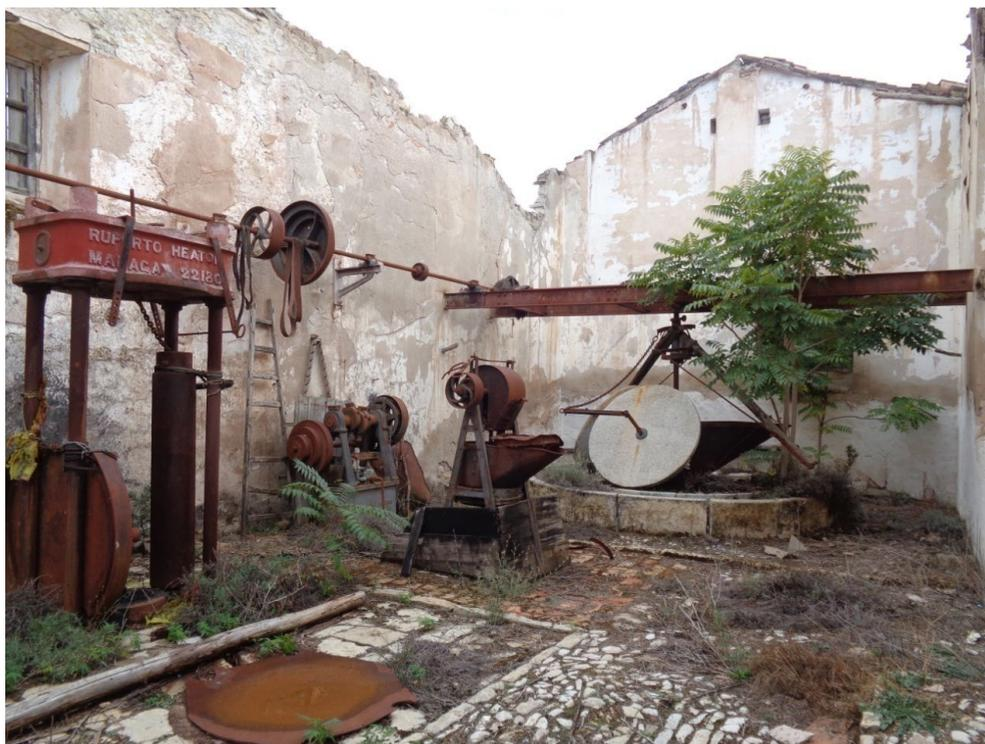
**Figura 23.** Prensa Hidráulica con su cuerpo de bombas, alfarje compuesto empiedro, rulos y tolva, para ser movidos por caballerías. (Fuente: Felipe Jiménez).
