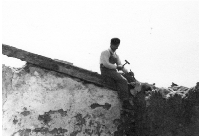
El Joan Torrell treballant a la teulada de la casa.
