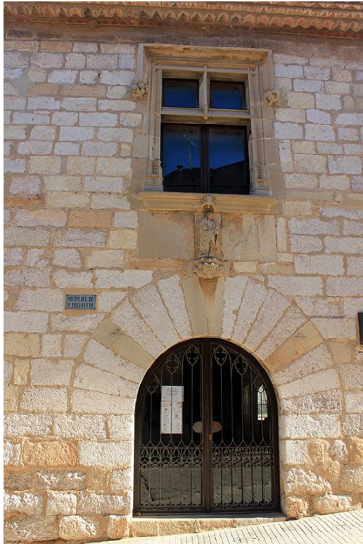
Façana de l'Hospital de Santa Magdalena de Montblanc
