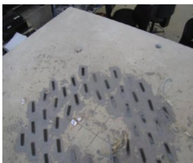
Figura 4. Losa con reforzamiento de laminados con PRFC. Fuente: [42].
