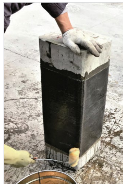
Figura 2. Proceso de reforzamiento de columna con enrollado de PRFC. Fuente: [37].
