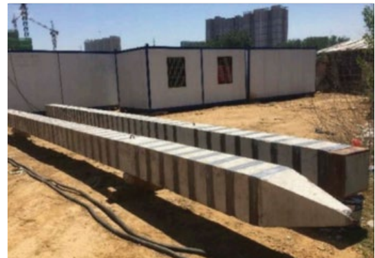
Figura 1. Pilote rectangular de concreto con aplicación de PRFC. Fuente: [35].
