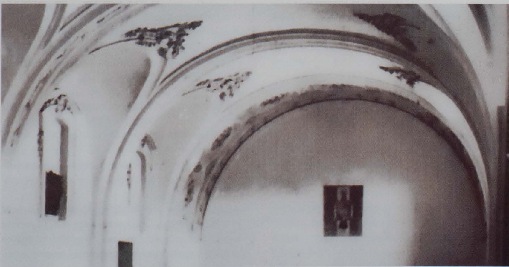
La bóveda original de hundió a finales del siglo XVIII, se reconstruyó inmediatamente y en 1793 fue bendecida de nuevo.
