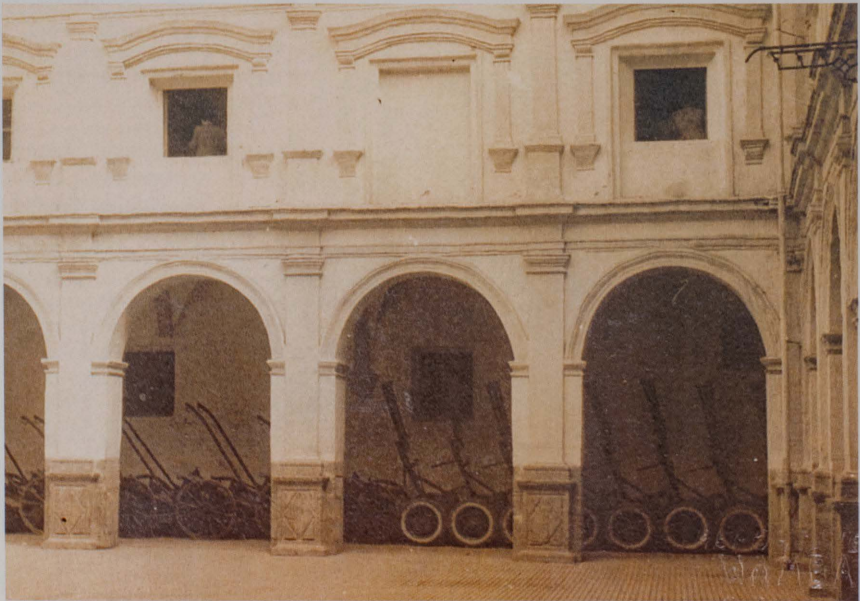
Claustro del convento. S. XVII ya convertido en cuartel. Entre los arcos se observa parte del armamento. Foto: Col. Prades.
