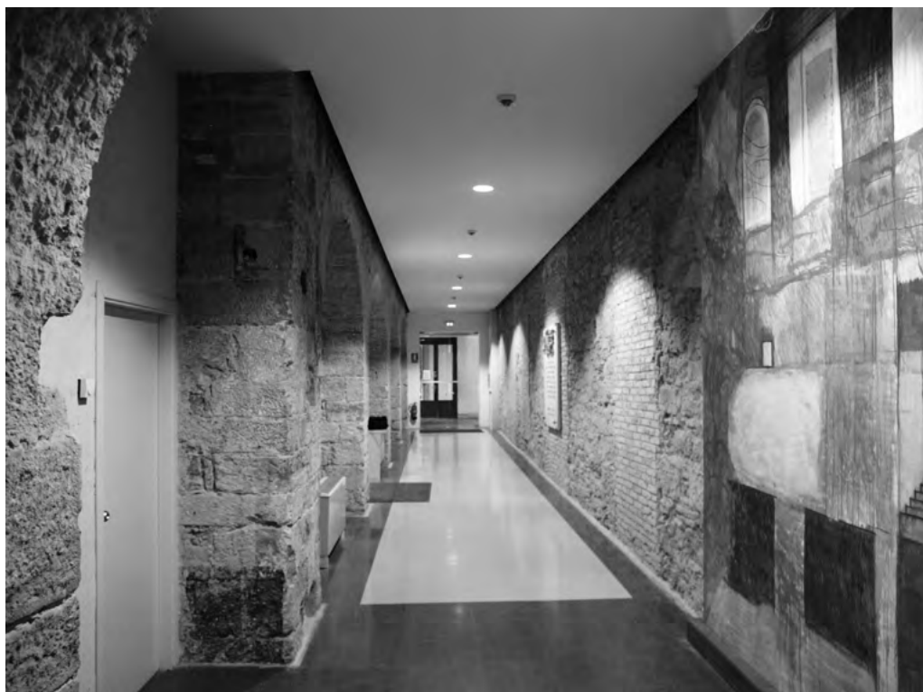
Fig. 5. Vista d'un corredor de l'actual Palau de la Diputació, des d'on es poden veure els murs originaris amb antics accessos tapiats i les arcades que donaven al pati o claustre.
