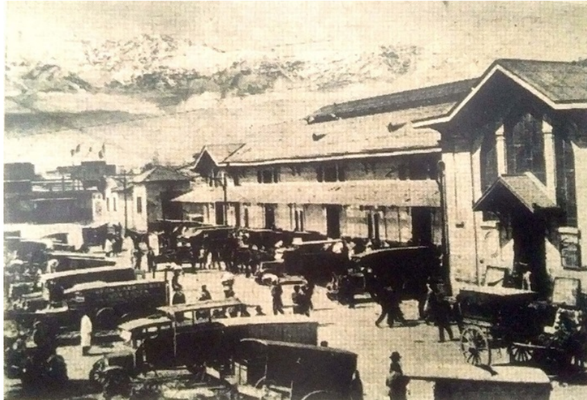
Figura 4. Matadero de Santiago. Vista parcial al pabellón de vacunos
