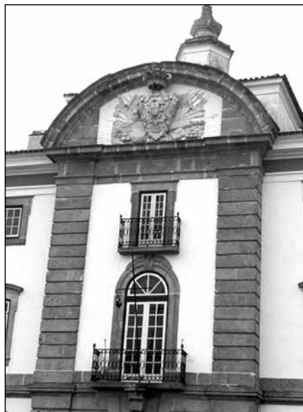
Fig, 30. Pórtico do Quartel dos Dragões de Évora
