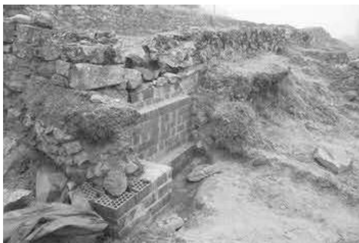
Construción de muro soporte en E048
