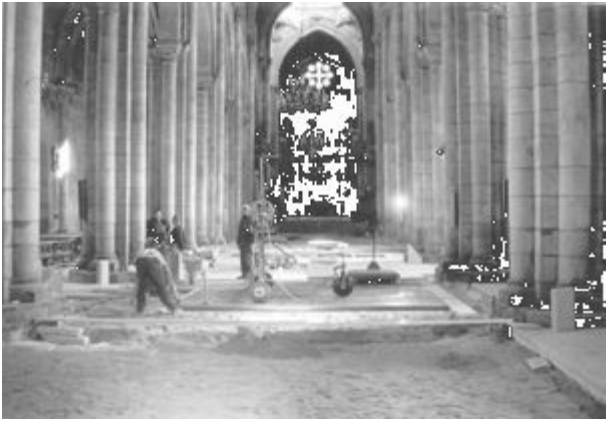
Catedral de Ourense. Obras de restitución de pavimento [© C.R. Cao]
