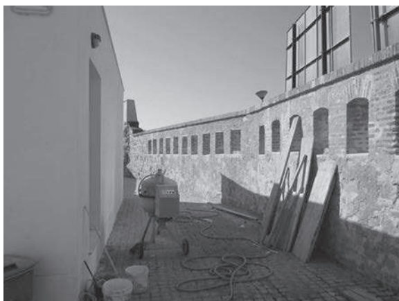
Recuperación de la tapia de fusileros que permitirá el recorrido de la cara interior de la muralla
