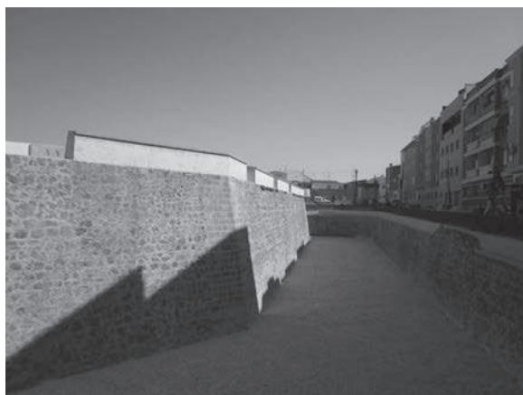
Limpeza y excavación del foso recuperando la geometría y línea de cornisa del monumento
