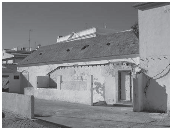
Paio do quartel do Casarão
