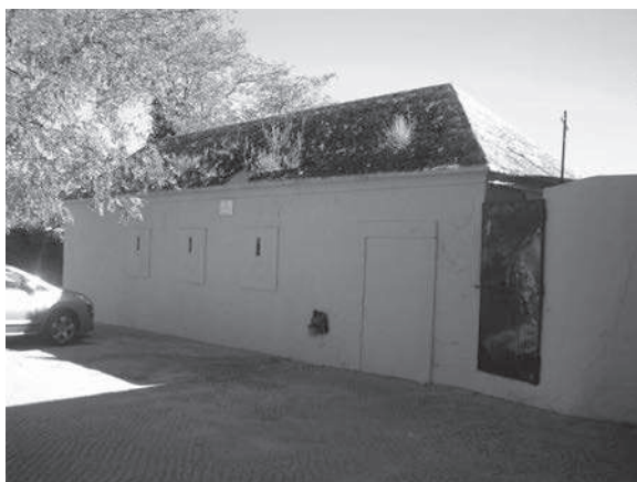
Paiol da bateria às portas da Esquina
