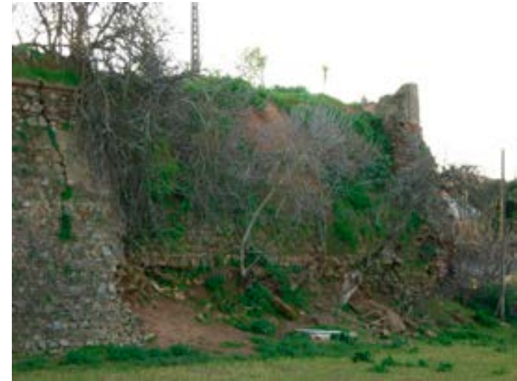
Nº 7.- Doble encamisado de piedra en el baluarte de la Corna. (J.M. Vázquez).
