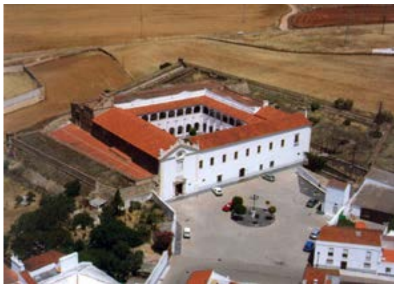
Nº 1.- Baluarte y convento de San Juan de Dios.
