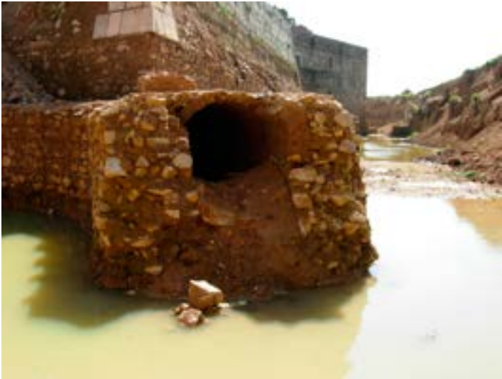
Nº 26.- Galería principal de la contramina, en el ángulo capital del caballero y baluarte. Las obras del vaciado quebraron su continuidad. [← Il. nº 23]. (J. M. Vázquez).
