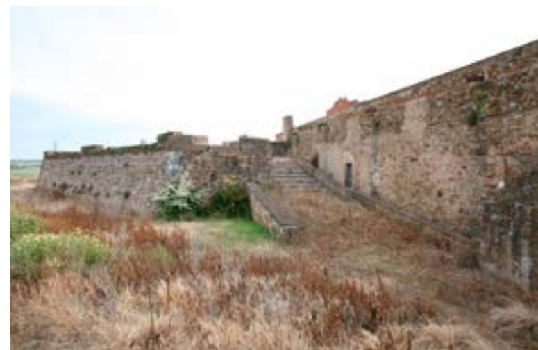
Nº 18.- Cara oeste y sur del caballero, tras la obra de 1986, con la rampa de acceso convertida en escalinata.(I. Puras).
