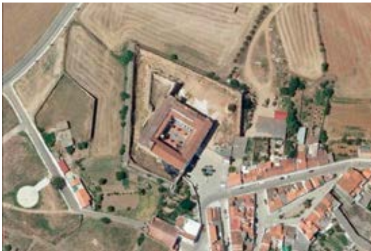
Nº 34.- Vista aérea del baluarte y caballero vaciados.
