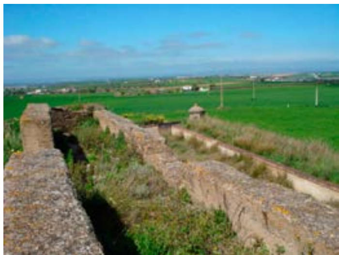
Nº 19.- Restos de los merlones, vacíos de sus tierras, en la cara norte del caballero. (I. Puras).
