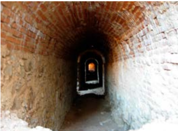
Nº 27.- Interior de la galería de contramina. (J.M. Vázquez).
