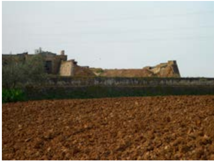
Nº 21.- Desplome de la cara norte del caballero desde la carretera de circunvalación. (J.M. Vázquez).
