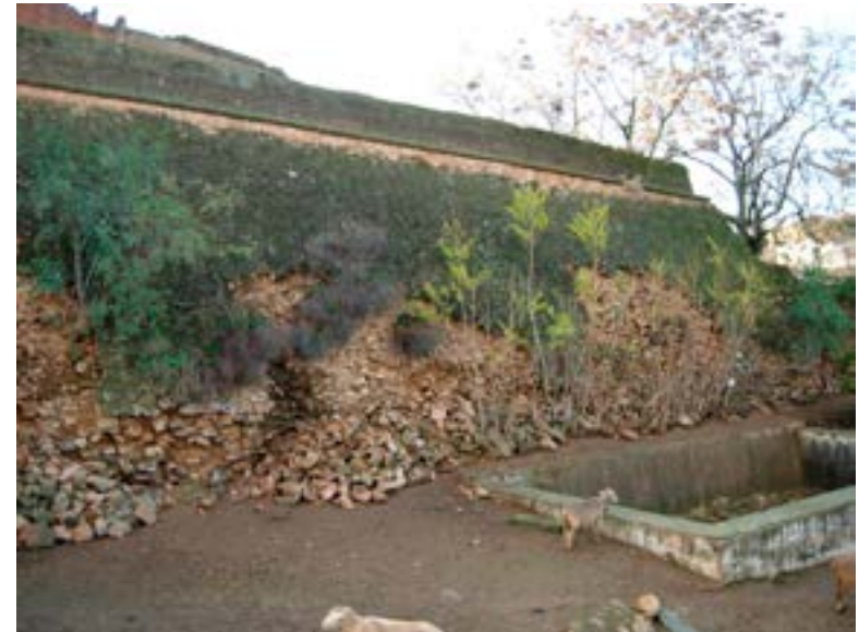
Nº 8.- Tramo de muralla entre el cuerpo de guardia de las Puertas Nuevas y el baluarte de la Concepción. Nótese la mala calidad de la fábrica, de piedra y barro. (J.M. Vázquez).
