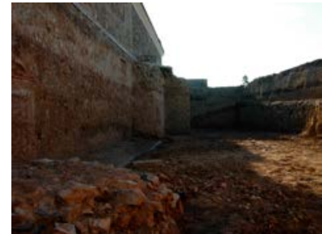
Nº 36.- Vaciado del baluarte. Cara sur. (J.M. Vázquez).
