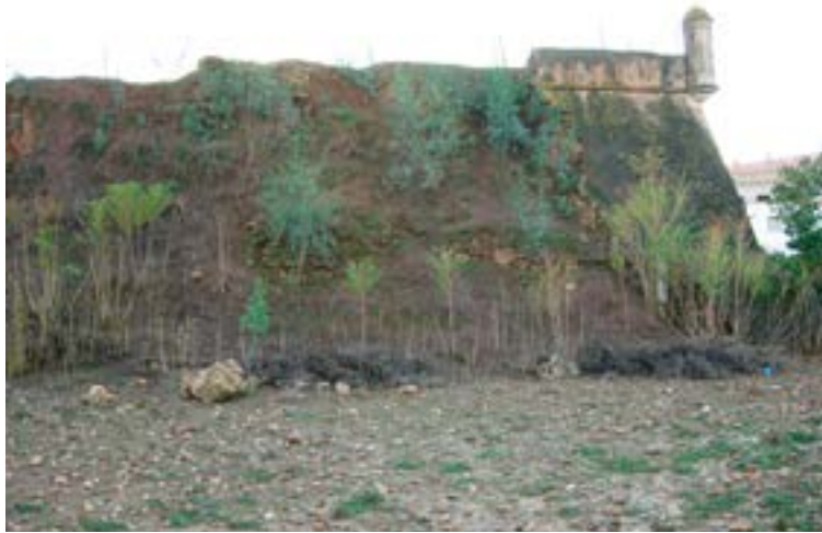
Nº 9.- Camisa de piedra directamente apoyada sobre la masa de tierras de la muralla en el baluarte de la Concepción. (J. M. Vázquez).
