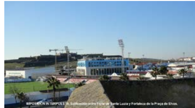
IMPOSICIÓN INTERPOLAR. Edificación entre Torre de Santa Luzia y Fortaleza de la Praça de Elvas.
