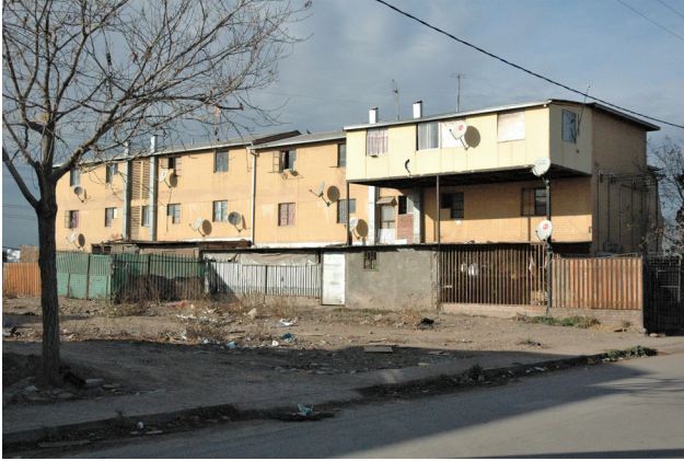
Figura 4. Tomas de terreno en primer piso y ampliaciones irregulares. Población Francisco Coloane, Bajos de Mena, Puente Alto
