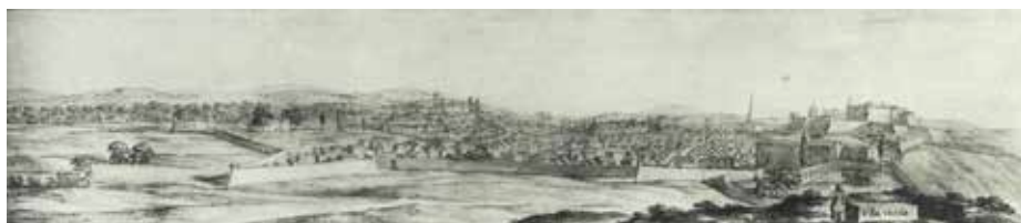
FIG. 12. Vila Viçosa vista por Baldi.
