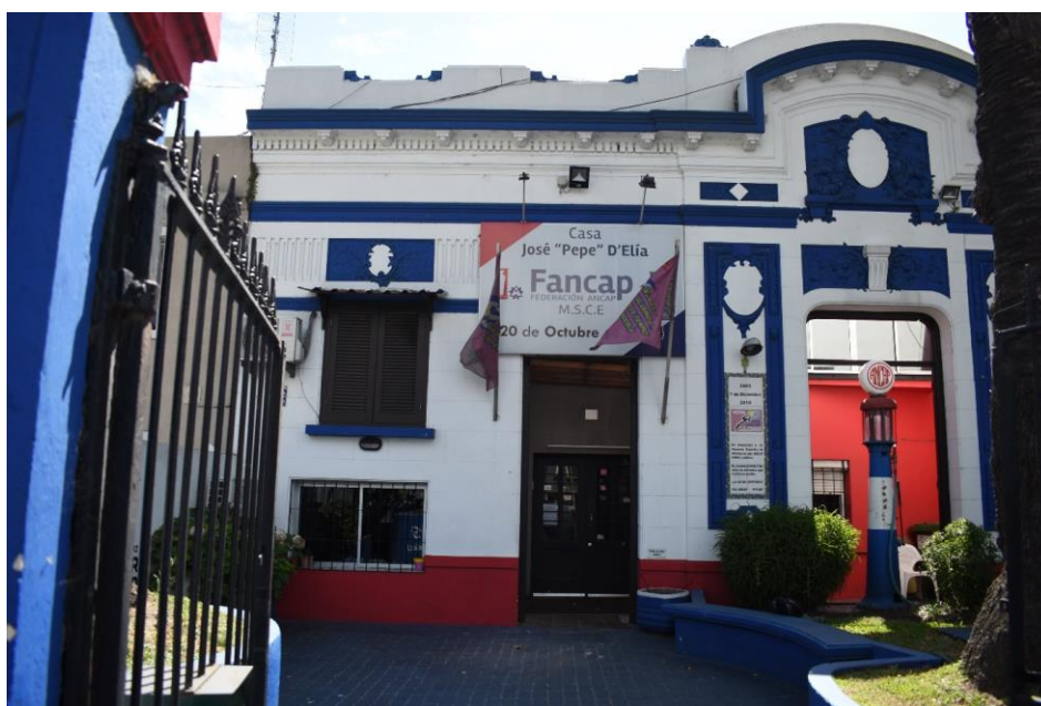
Imagen 4. Foto de la fachada de FANCAP donde se encuentra un memorial. Foto de autor, 2020
