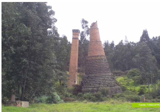
Figura 2: Actuales ruinas de la Ferrería y la Compañía de Hilados y Tejidos de Samacá.
