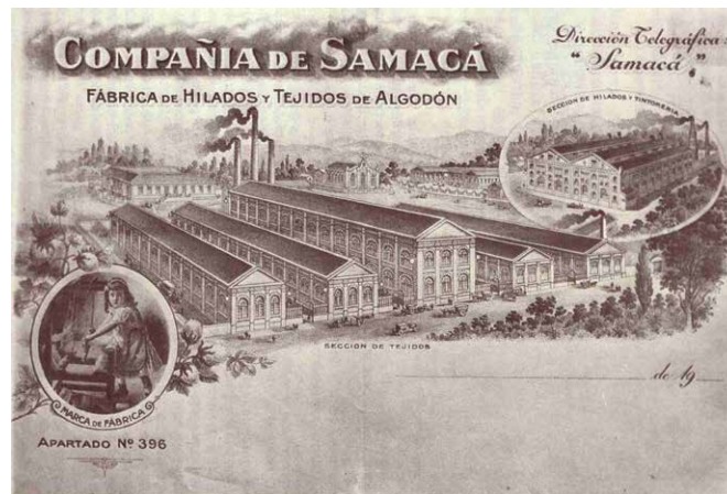
Figura 1: Edificio de las antiguas instalaciones de la Compañía de Samacá, Fábrica de Hilados y Tejidos de Algodón 3
