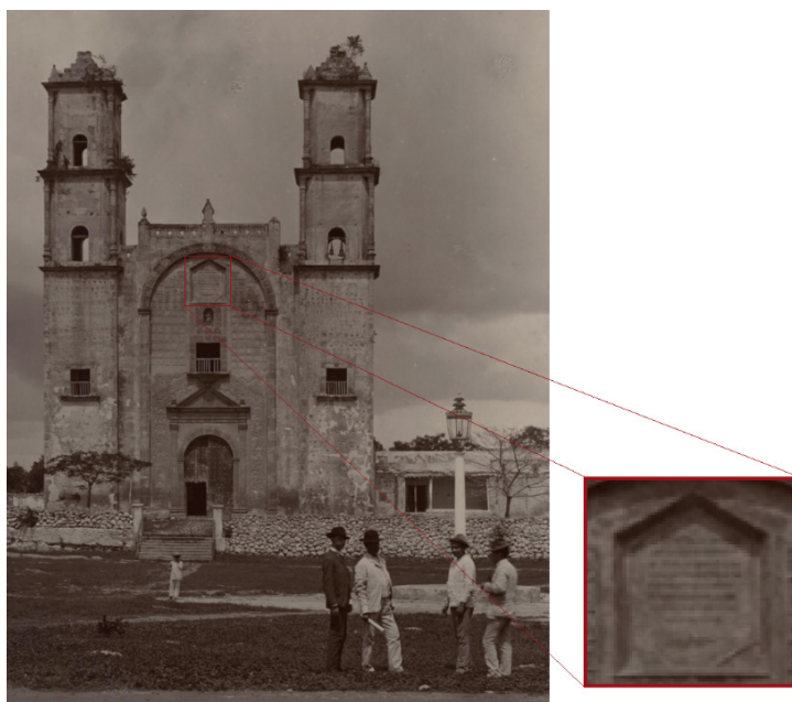
Figura 6. Cartela de la fachada de la iglesia de Peto.
