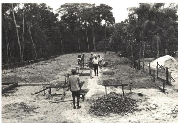
Figura 6 - Construção Severiano Porto
