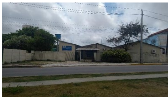
Figura 10 – Escola que atende a população da Comunidade do Pilar.
