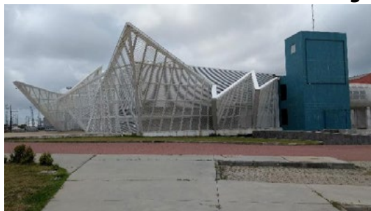
Figura 9 – Edifício anexo ao Terminal Marítimo de Passageiros no Armazém 7.
