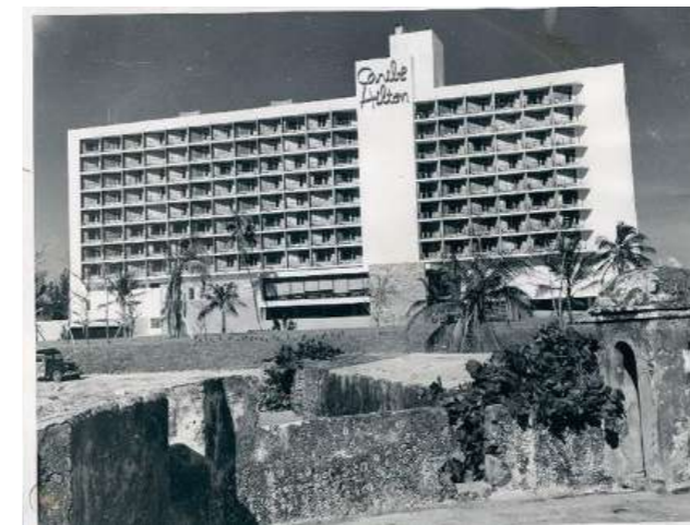
Figura 15. El Hotel Caribe Hilton, edificado en 1949 a la entrada de la isleta de San Juan (Puerto Rico). Las ruinas del Fortín de San Jerónimo, a los pies de la foto.
