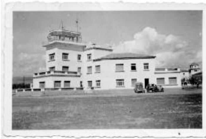
Torre de control i secció de guàrdia aèria.
