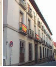
Fig. 1b. Estado actual de la parte que se construyó y se ha rehabilitado poco ha
