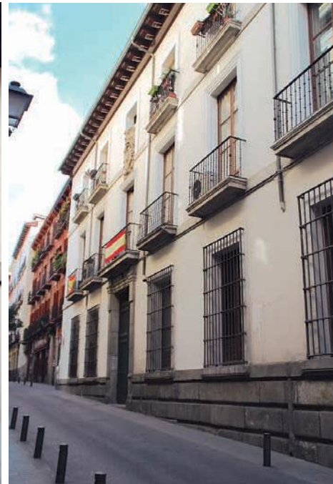
Fig 2b. Tramo de fachada con la disposición del blasón
