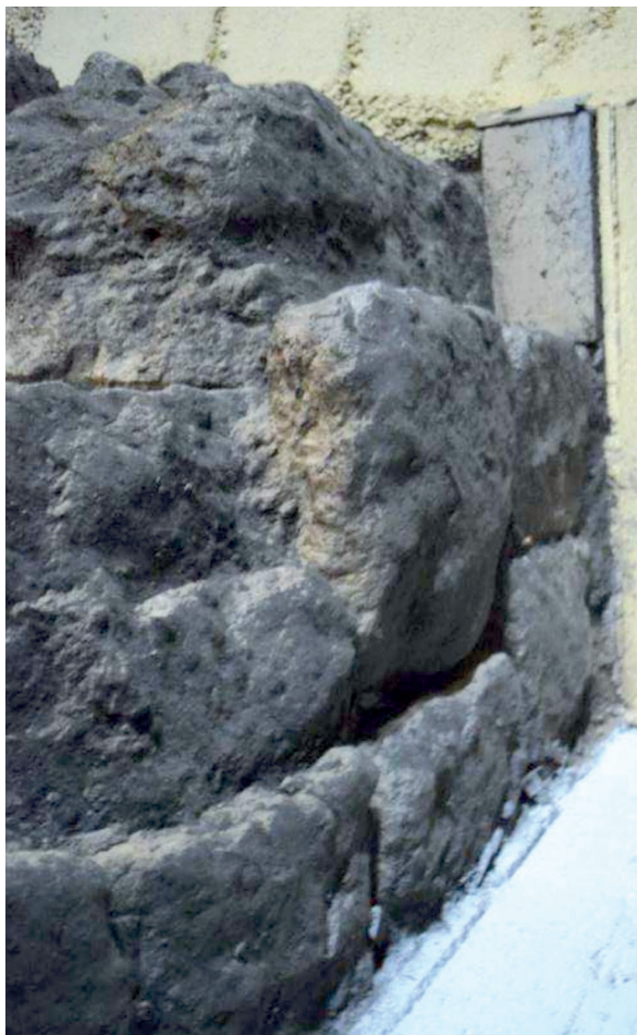
Fig. 5: Preparación a base de sillares cuadrangulares para la instalación de la muralla islámica.
