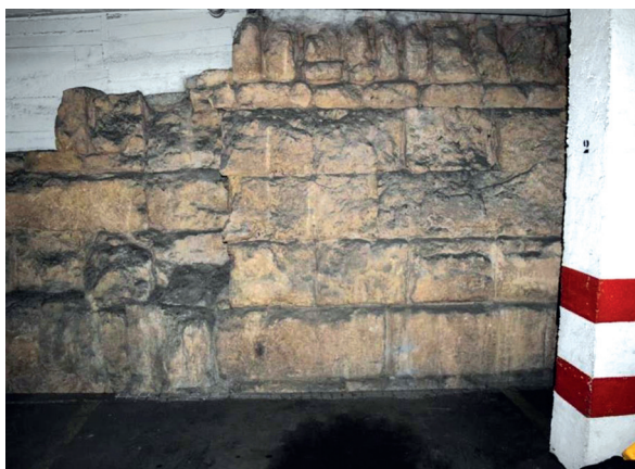
Fig. 2: Tramo de la muralla islámica en Plaza de Colón n° 9.
