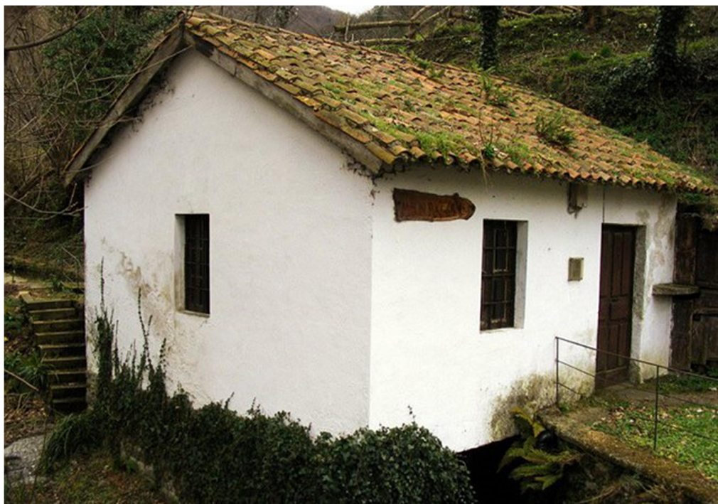
La "casita" y Molino en la actualidad. Imagen https://www.molindeadela.es/galeria/
