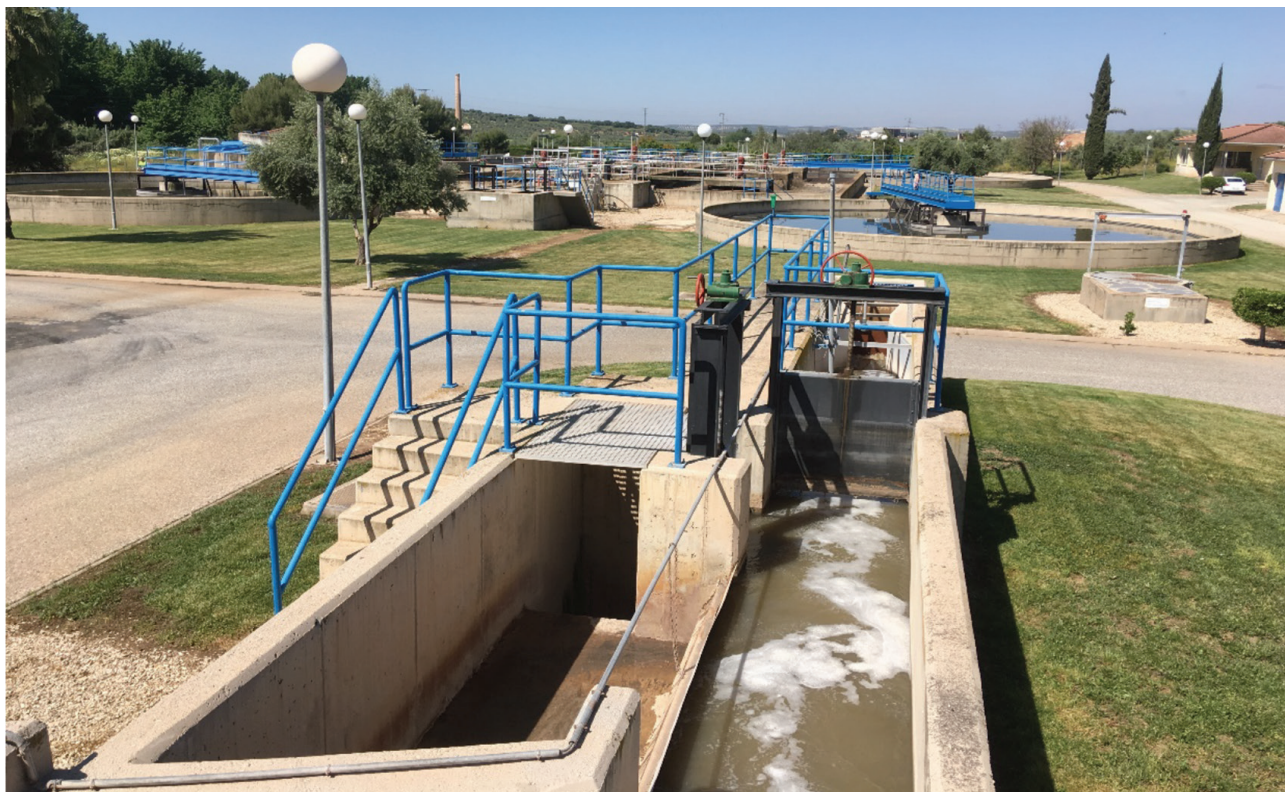
Figura 1. Depuradora de aguas residuales de Alcalá la Real
