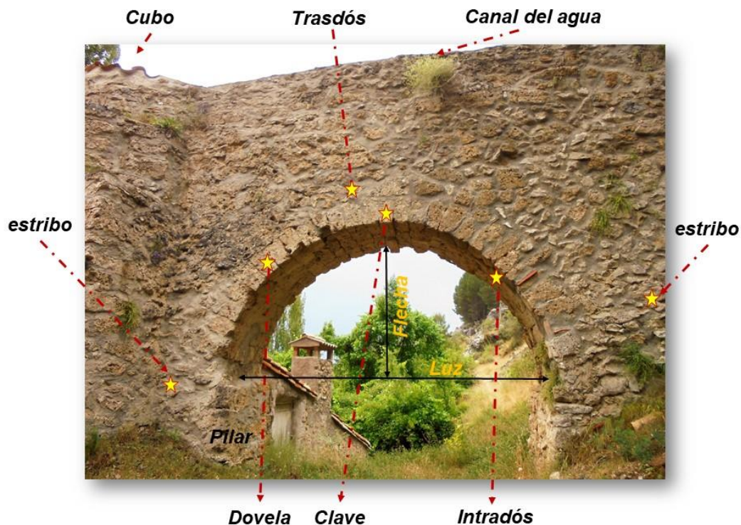
fg.53) Detalles del arco del acueducto
