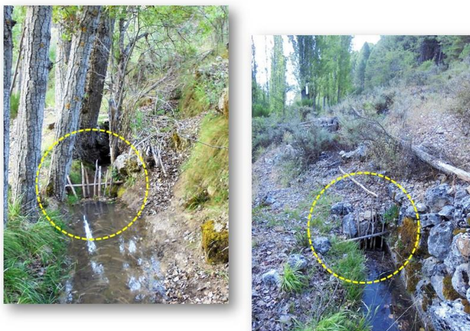
Fg.48) Rejillas para evitar el paso de hojas en el cauce.
