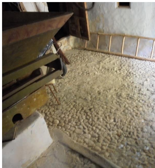
fg.19) Detalle del pavimento empedrado con chino de canto rodado de río en el zaguán de entrada al molino.
