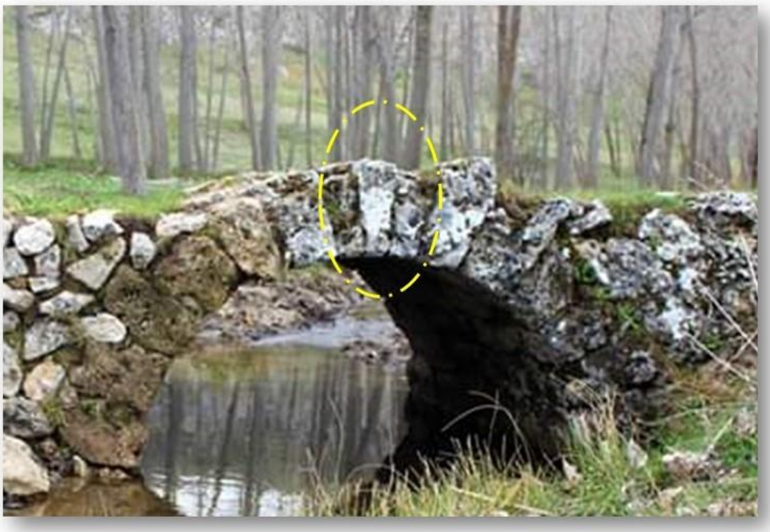
fg.55) Detalle de la clave del puente en Cañada Hermosa
