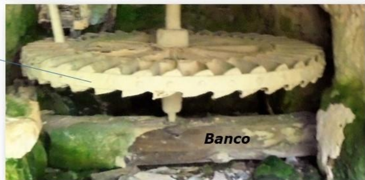
Fg.68) Vista del rodezno
