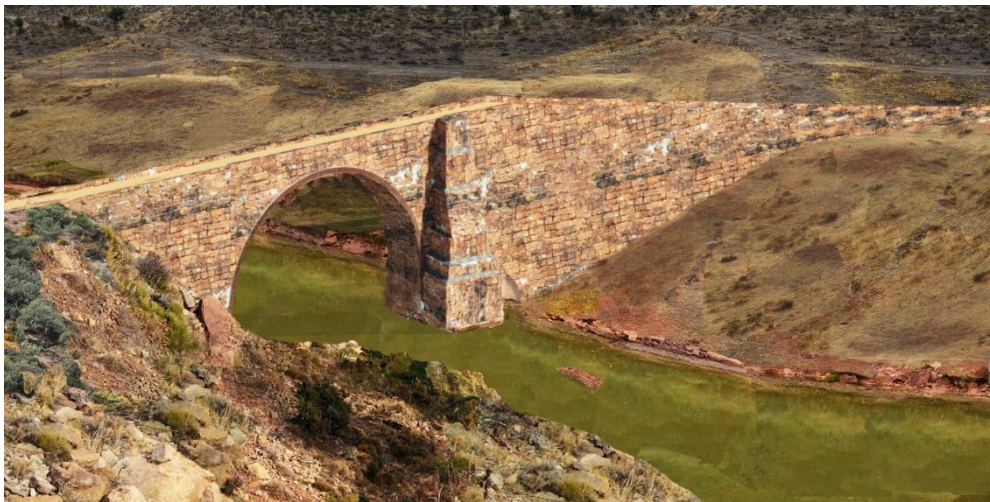
Fg.58) Recreación virtual aguas abajo del puente de Andrés de Vandelvira sobre el río Guadalmena, en el límite de las comunidades de Andalucía y Castilla-La Mancha. Se aprecia el contrafuerte de diferentes secciones escalonadas en sillares de piedra.
