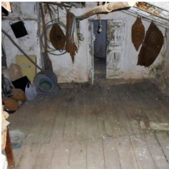
fg.12) Forjado con entablado de madera. Acceso a la máquina de la borra desde el molino.
