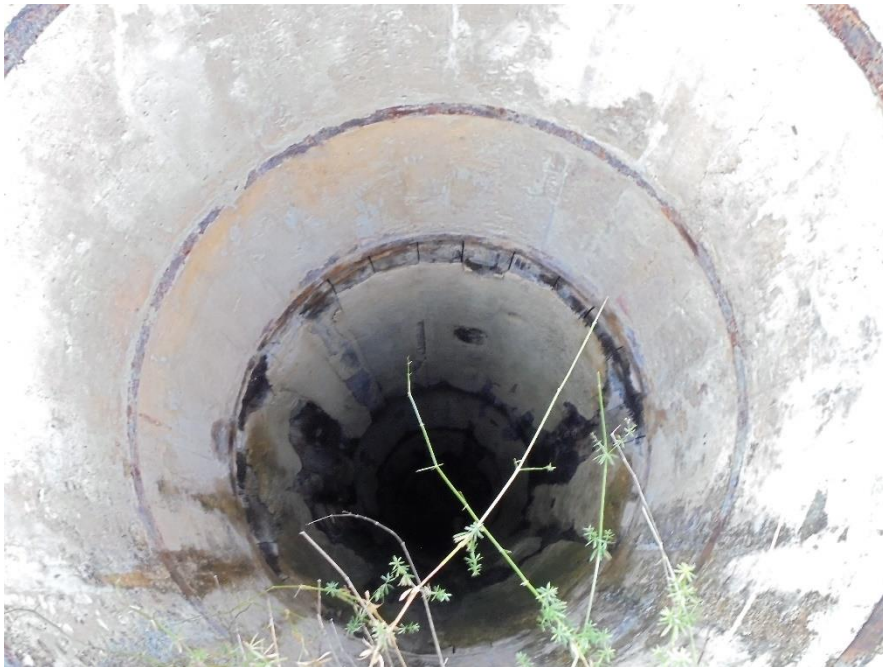
Fg.62) Vista interior del cubo. Se aprecian las tablas de madera que lo recubren en varias capas, así como la cal solidificada en las paredes.
