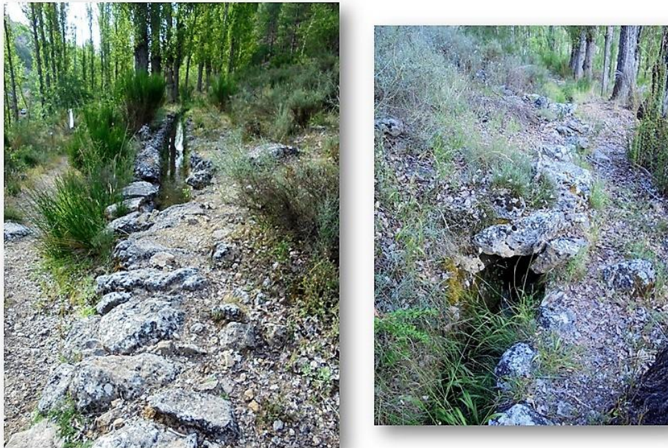
Fg.45) Detalle de la cubrición de algunos tramos del caz
