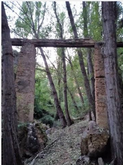
Canal de entrada del agua al cubo sobre pilares de piedra de toba.
