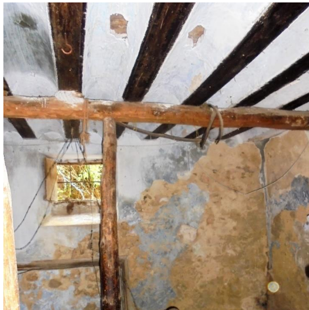
fg.10) Forjado con vigas de madera. Sala ubicación del generador y turbina en edificio anexo.
