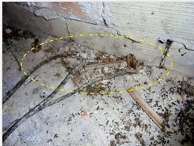
Fg.29) Detalle de aisladores interiores. I
