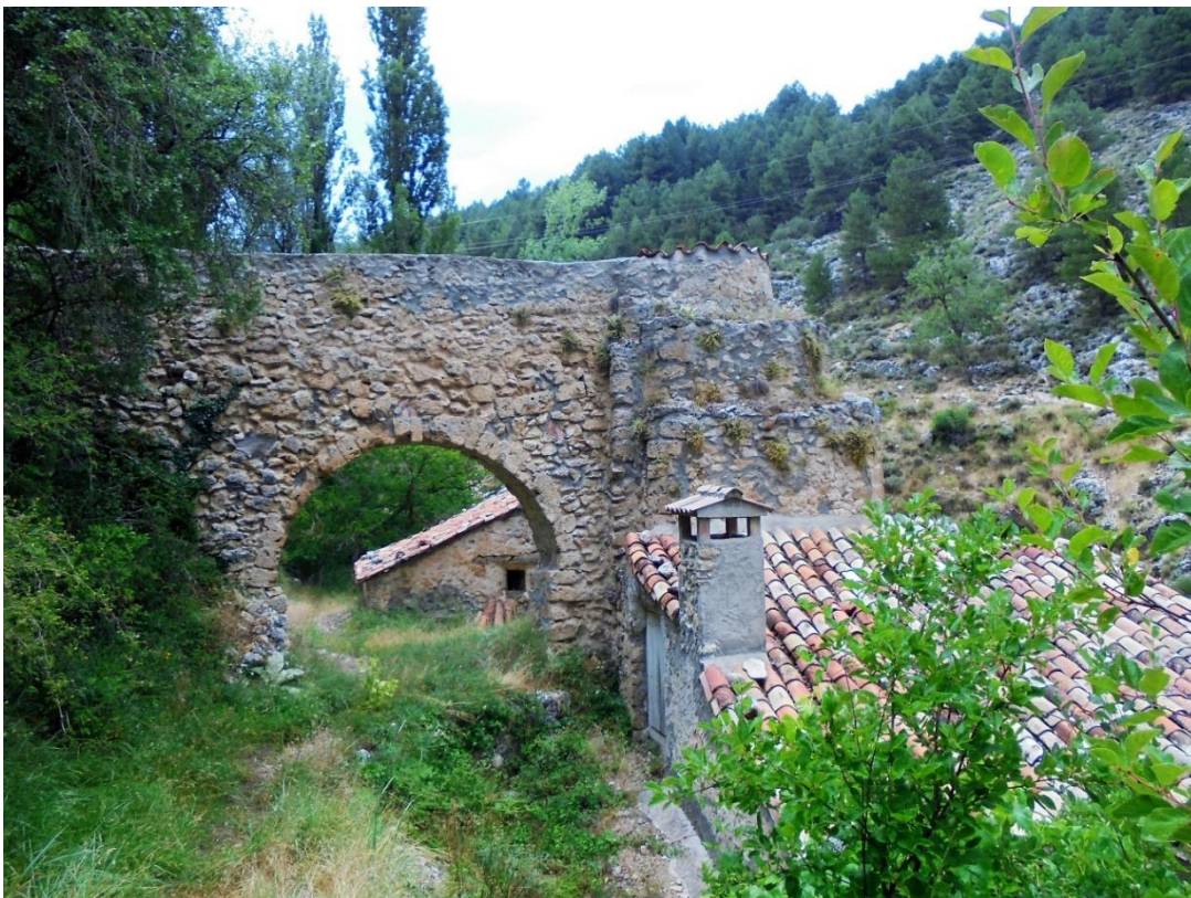
Fg.50) Vista del acueducto aguas abajo arroyo Zumeta
