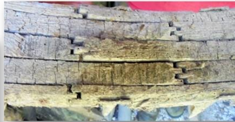
Detalle de las tablillas machihembradas con perfil curvo que forman la corona del rodezno
