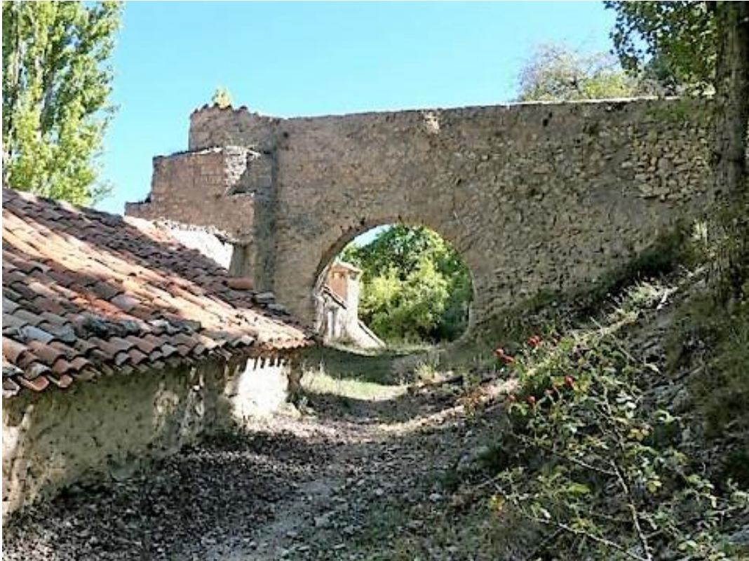
Fg.49) Vista del acueducto aguas arriba arroyo Zumeta
