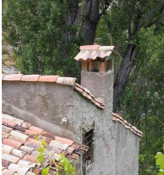
fg.08) Fachada cerramiento exterior recubierta de mortero de cal y arena.
