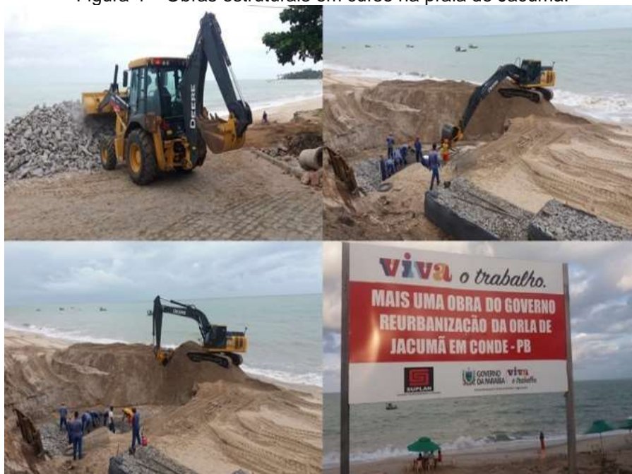
Figura 4 – Obras estruturais em curso na praia de Jacumã.
