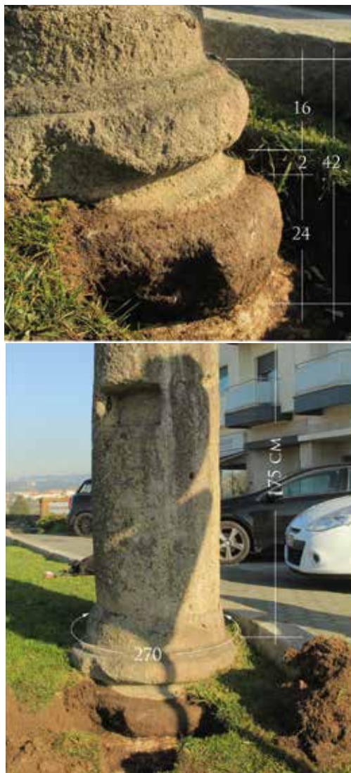
Perímetro da base = 270 cm | Diâmetro = 270 : 3.14 = 85.98 Raio = 85.98 : 2 = 42.99 = módulo (1/2 do diâmetro do fuste medido na base)
