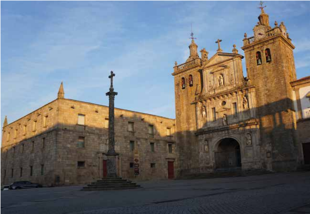
Fig. 1 – Adro da Sé: à esquerda, o Museu Grão Vasco e, à direita, a fachada da Sé.
