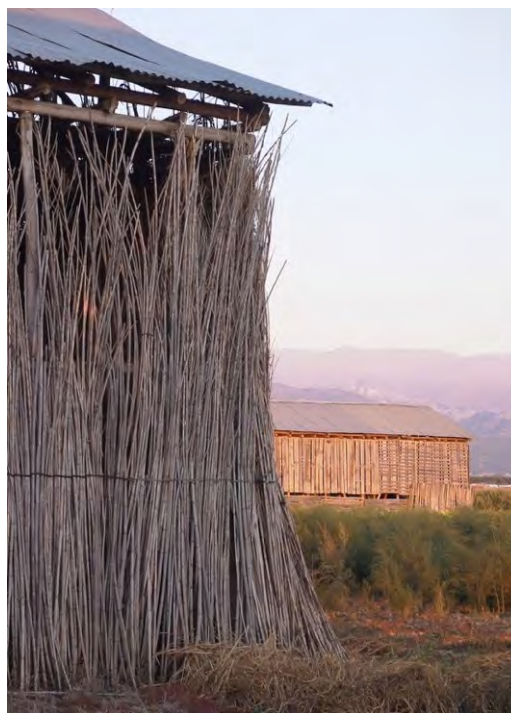
Figura 3: Secaderos de tabaco con diversos cerramientos de ramas y cortezas de chopo (Purchil) Fuente: Fotografía de Antonio Jiménez Torrecillas
