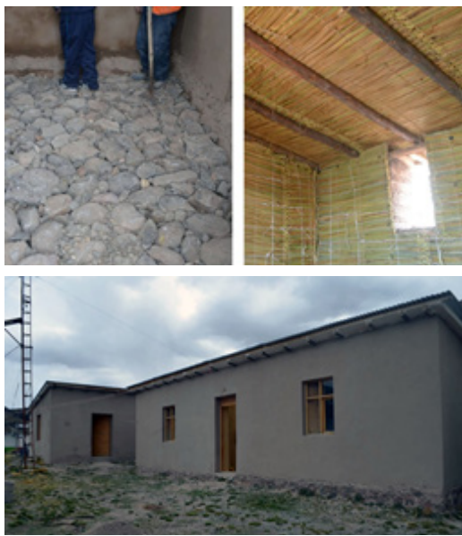
Figura 7: Fotos del prototipo: Detalles del piso antihumedad (arriba izquierda), muro de adobe con capa de totora, ambas confinadas con el sistema antisísmico de drizas (arriba derecha) y prototipo terminado (abajo).
