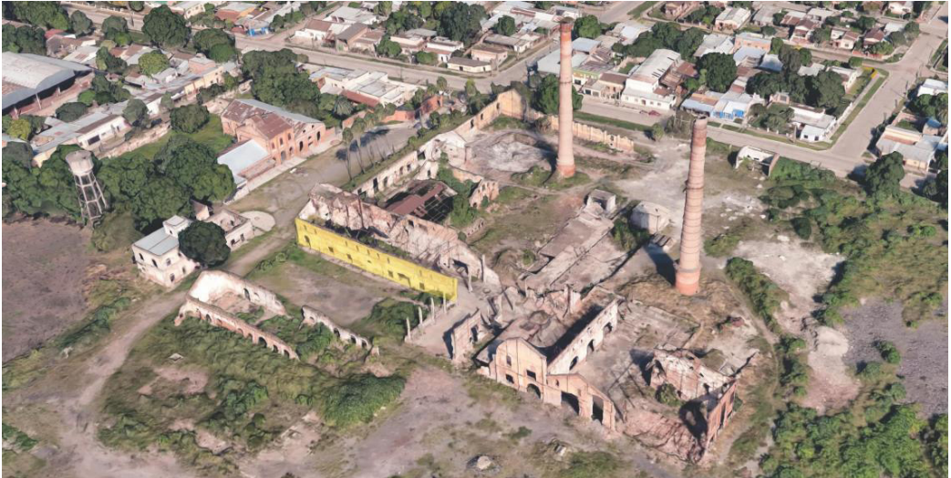
FIGURA 3 • Salón de Cocimientos del SIL en 1922 y en la actualidad. Fuente: Archivo ISES.
