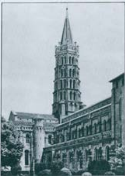
TOLOSA. Basílica de Sant Serni.
