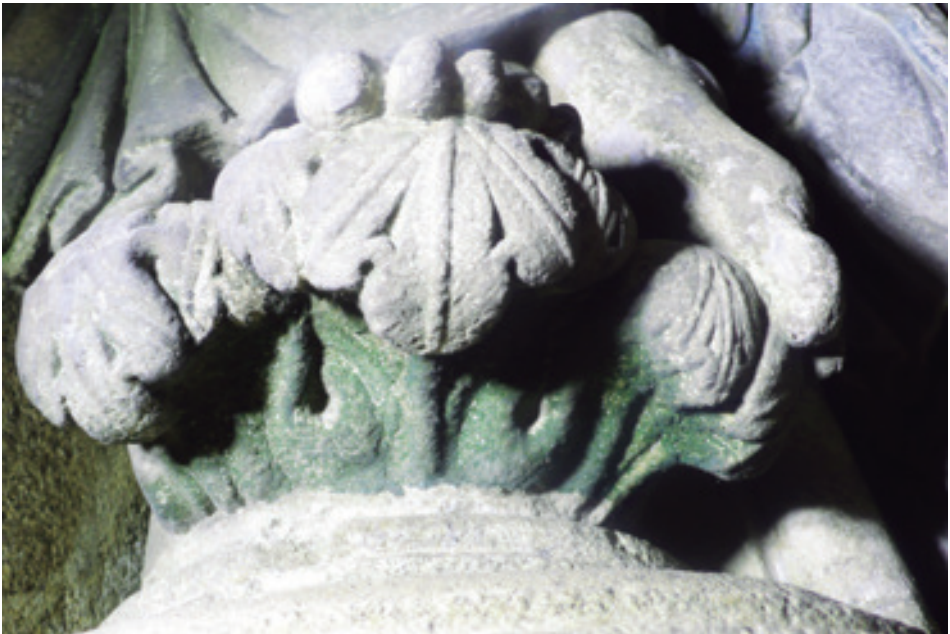
Fig-3. Dos áreas con coloraciones verdes debidas a cianobacterias en zonas donde se mantiene mejor la humedad, los pliegues de las túnicas de las figuras, y en tallas con ornamentación.
