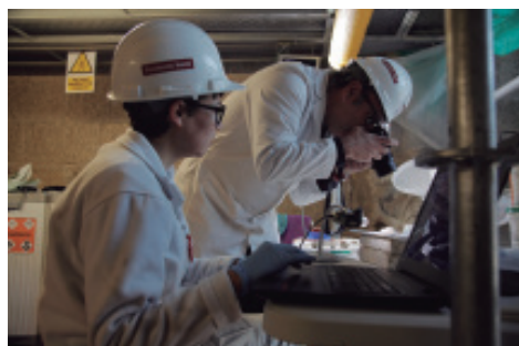
Ensayos de tratamientos en la obra. FB-FC
