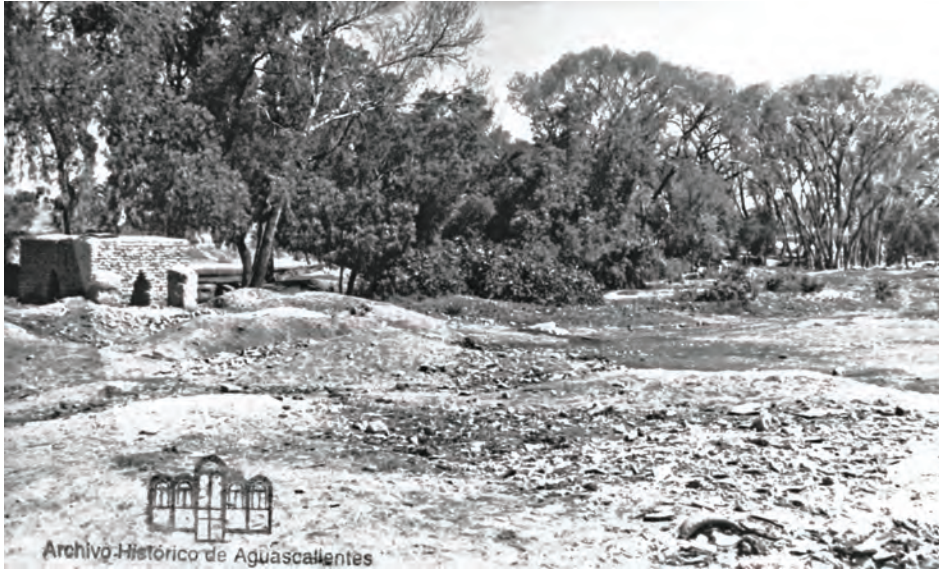
Figura 4. Fábrica de ladrillos ubicada junto al cauce del arroyo
