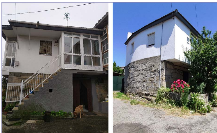
Fig. 3. Fachada principal (izq.) y parte posterior (dcha.) de C1. Figura propia.
