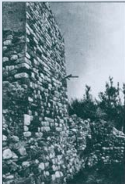
Cara de la torre on hi havia el reposador per als tudons, que hem assenyalat amb una fletxa. Fixeu-vos, també, amb el talús que formen els murs de la seva part baixa.
