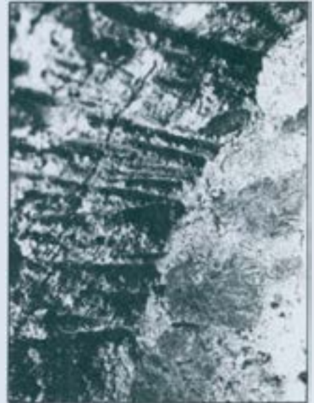
Detall del sostre de l'habitacle inferior de la torre. Observeu-ne l'empremta, molt marcada, de l'encanyissat i l'encordillat que és una de les característiques del romànic d'aquella època, quant a la construcció de voites de canó o lleugerament apuntades.
