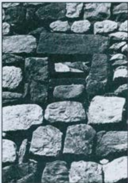
Detall de la finestreta-reposador per a l'entrada i eixida dels coloms.
