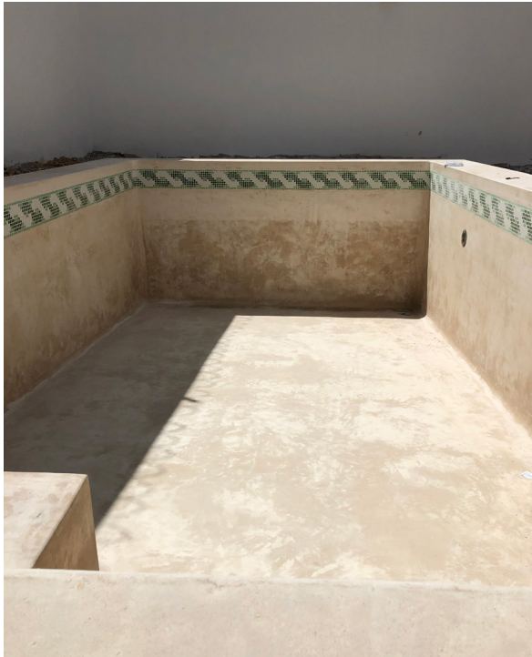
Figura 12. Piscina con acabado realizado con un mortero a base de extracto de chucum natural, cemento y polvo de piedra. En ella, la extracción del chucum y la aplicación del acabado fueron realizados por Manuel Vicaría (M. Martínez Barreiro)
