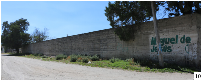
Figura 9 a y b. Tapias de piedra poma y cal de reciente construcción, Tepeyahualco, Puebla (Acervo del LABPySCT, María de los Ángeles Vizcarra)
