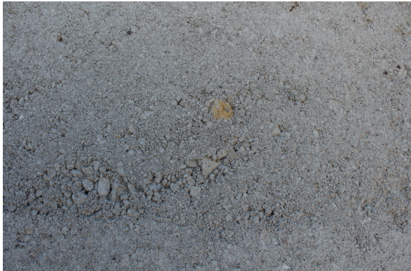
Figura 13. Detalle de la granulometría de los componentes de la mezcla de la tapia, Tepeyahualco, Puebla (Acervo del LABPySCT, María de los Ángeles Vizcarra)
