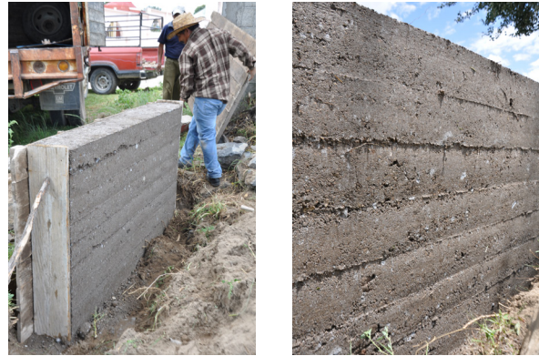
Figura 18. Proceso constructivo: descimbrado y tapia terminada, Tepeyahualco, Puebla (Acervo del LABPySCT, María de los Ángeles Vizcarra)
