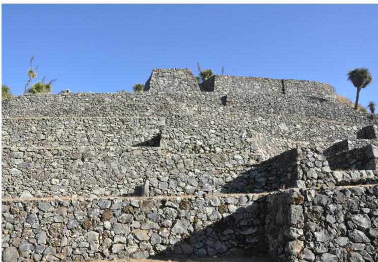
Figura 4. Talud en muros de Cantona, Puebla (María de los Ángeles Vizcarra)
