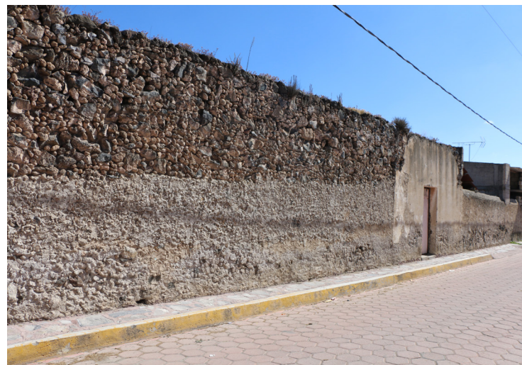
Figura 5. Construcción con piedra con revestimientos de cal y rocas volcánicas, Tepeyahualco, Puebla (Acervo del LABPySCT, María de los Ángeles Vizcarra)
