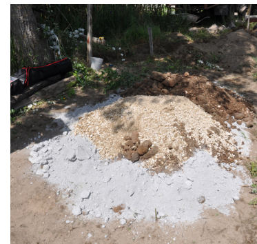
Figura 16. Materiales mezclados: en seco y ya con el grado exacto de humedad, Tepeyahualco, Puebla (Acervo del LABPySCT, María de los Ángeles Vizcarra)
