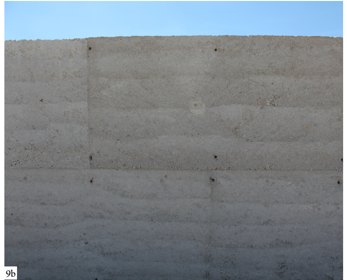
Figura 9 a y b. Tapias de piedra poma y cal de reciente construcción, Tepeyahualco, Puebla (Acervo del LABPySCT, María de los Ángeles Vizcarra)
