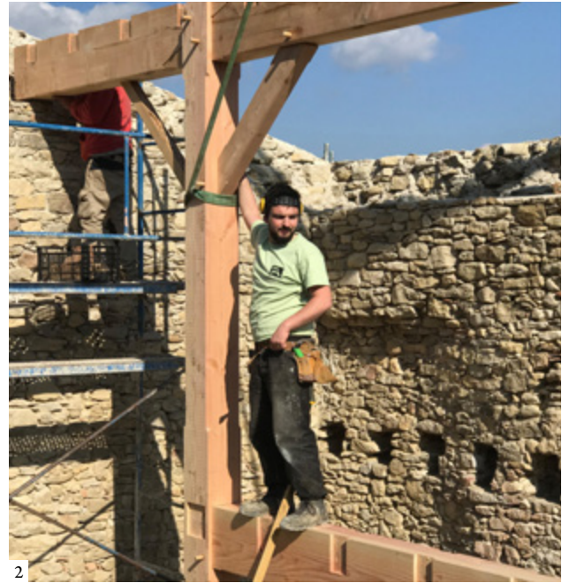
1: Using mud as thermal insulation 2: Solid timber structure, without metal anchors | 1: Uso del barro como aislamiento térmico 2: Estructura de madera maciza, sin conectores metálicos | 1 e 2: Uso do barro como isolamento térmico 2: Estrutura em madeira maciça, sem conexões metálicas
