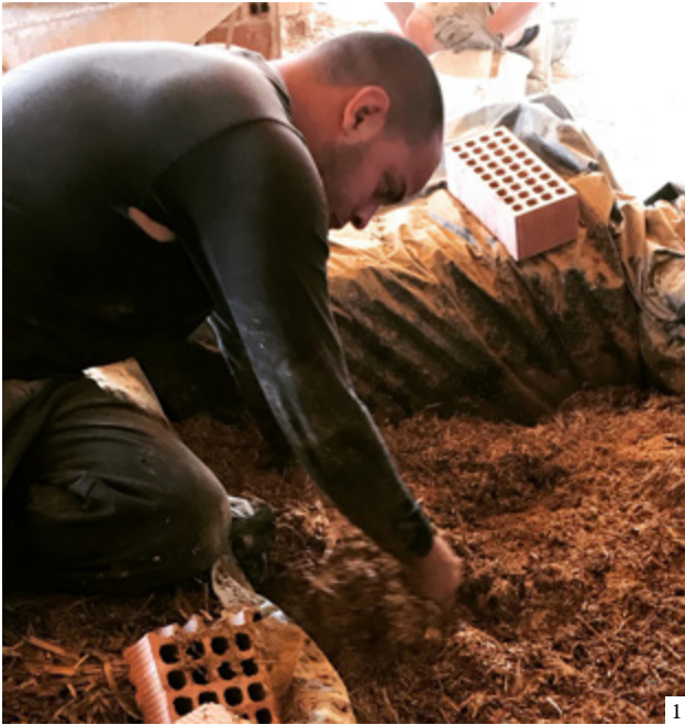
1: Using mud as thermal insulation 2: Solid timber structure, without metal anchors | 1: Uso del barro como aislamiento térmico 2: Estructura de madera maciza, sin conectores metálicos | 1 e 2: Uso do barro como isolamento térmico 2: Estrutura em madeira maciça, sem conexões metálicas
