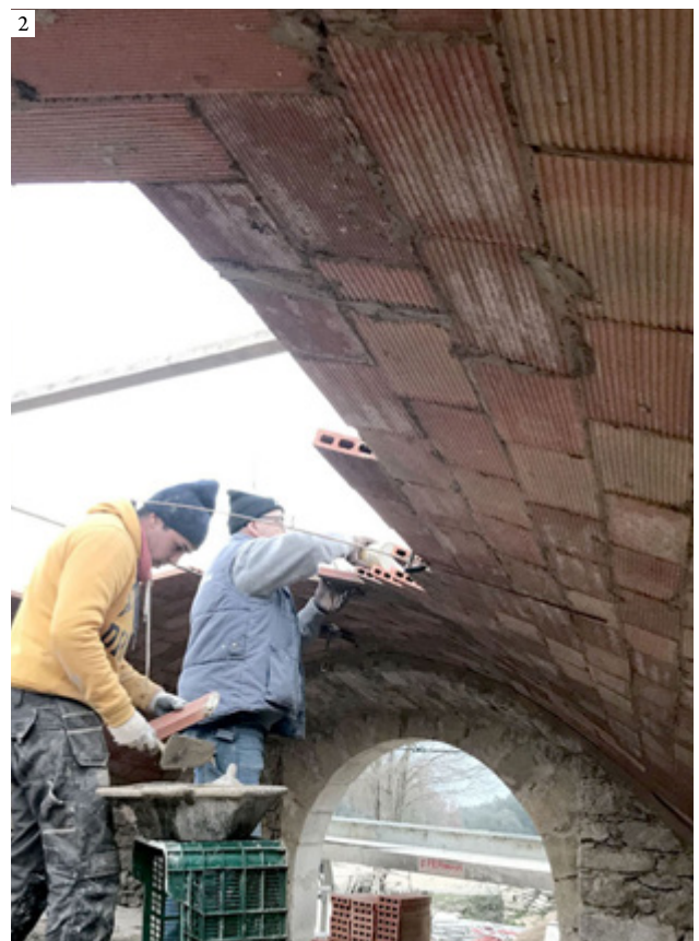
1 and 2: Master craftsmen working on the stone walls and vaulted ceilings | 1 y 2: Maestros artesanos trabajando en las paredes de piedra y en los techos abovedados | 1 e 2: Mestres artesãos a trabalhar nas paredes em pedra e nos tectos abobadados
