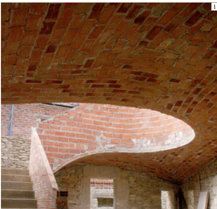
1: There are no geometrical or structural difficulties that the timber or Catalan vault cannot solve 2: Staircase and natural light entering into the ground floor | 1: No existen dificultades geométricas o estructurales que la bóveda tabicada o catalana no pueda resolver 2: Escalera y entrada de luz natural en planta baja | 1: Não existem dificuldades geométricas o estruturais que a abóbada tabicada ou catalã não resolva 2: Escada e entrada de luz natural no rés-do-chão (2: Antonio Navarro)
