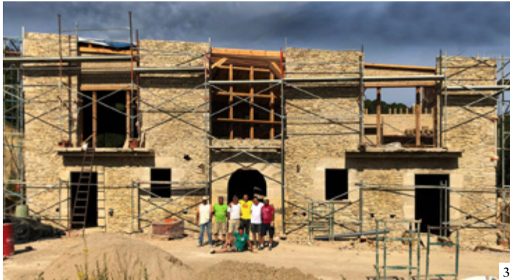
1, 2 and 3: Reconstruction process | 1, 2 y 3: Proceso de reconstrucción | 1,2 e 3: Processo de reconstrução
