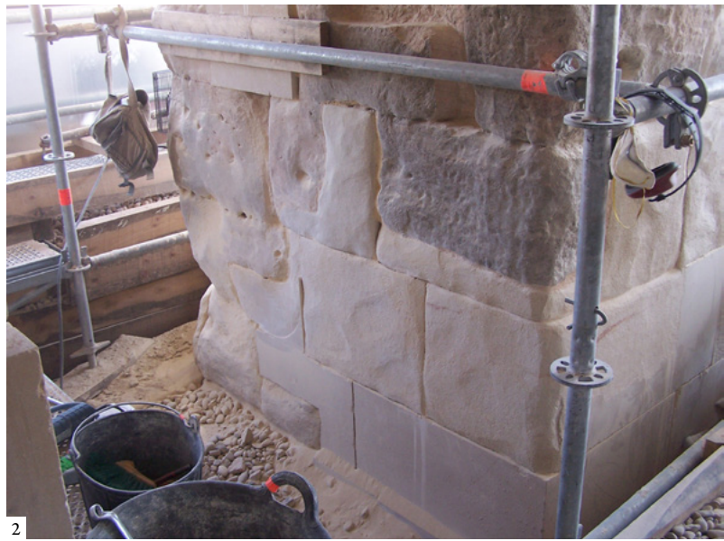
1: View of the western arch, once the replacement of the stonework of the base and the interior of the arch jambs had been completed 2: Superficial carving of the new ashlars | 1: Aspecto del arco occidental, una vez finalizada la reposición de la cantería del basamento y del interior de las jambas 2: Modelado superficial de los sillares nuevos | 1: Aspecto do arco occidental, uma vez finalizada a reposição da cantaria do embasamento e o interior das jambas 2: Modelado superficial dos silhares novos (1, 2: Rodrigo de la Torre)
