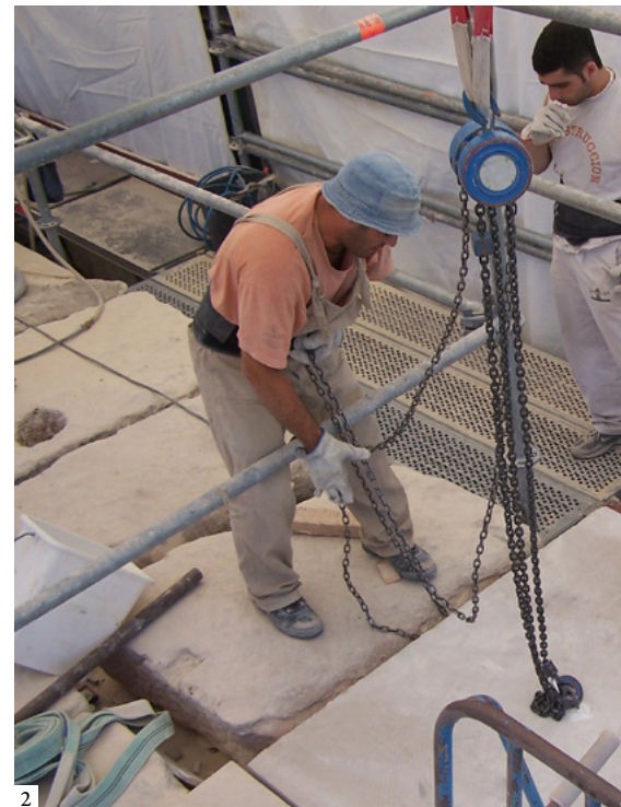
1: New ashlar prepared to adjust the templates of the lateral joint and the extrados 2: Replacement of one of the cornice stone slabs 3: Adjusting the templates of the joint between an original part and its graft | 1: Sillar nuevo preparado para ajustar las plantillas de la junta lateral y el trasdós 2: Reposición de una de las losas de la cornisa 3: Ajuste del aplantillado de la junta entre una pieza original y su injerto | 1: Silhar novo preparado para adaptar-se ao modelo da junta lateral e tardo 2: Reposição de uma das lajetas da cornija 3: Ajuste do modelo da junta entre a peça original e o enxerto (1and 3: Rodrigo de la Torre 2: Artelán restauración, S.L.)
