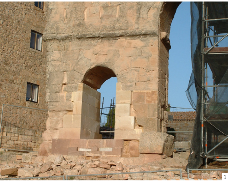
1: View of the western arch, once the replacement of the stonework of the base and the interior of the arch jambs had been completed 2: Superficial carving of the new ashlars | 1: Aspecto del arco occidental, una vez finalizada la reposición de la cantería del basamento y del interior de las jambas 2: Modelado superficial de los sillares nuevos | 1: Aspecto do arco occidental, uma vez finalizada a reposição da cantaria do embasamento e o interior das jambas 2: Modelado superficial dos silhares novos (1, 2: Rodrigo de la Torre)
