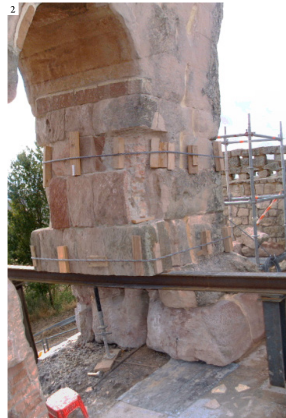
1: The western minor arch after emptying the soil fillings, showing the partial loss of its foundation 2: Western pilaster once propped, with an opus caementicium platform under the recovered base, awaiting the replacement of the sandstone orthostates | 1: El arco menor occidental tras el vaciado de los rellenos, mostrando la desaparición parcial de la cimentación 2: Pilastra occidental apeada, con plataforma de opus caementicium bajo el basamento recuperada, esperando la reposición de los ortostratos de arenisca | 1: O arco menor ocidental após o esvaziamento dos enchimentos, a mostrar a ausência parcial das fundações 2: Pilastra ocidental sustentada, com plataforma de opus caementicium por baixo do embasamento recuperado, à espera da reposição dos ortóstatos de arenito (1, 2: Junta de Castilla y León. José María Rincón)
