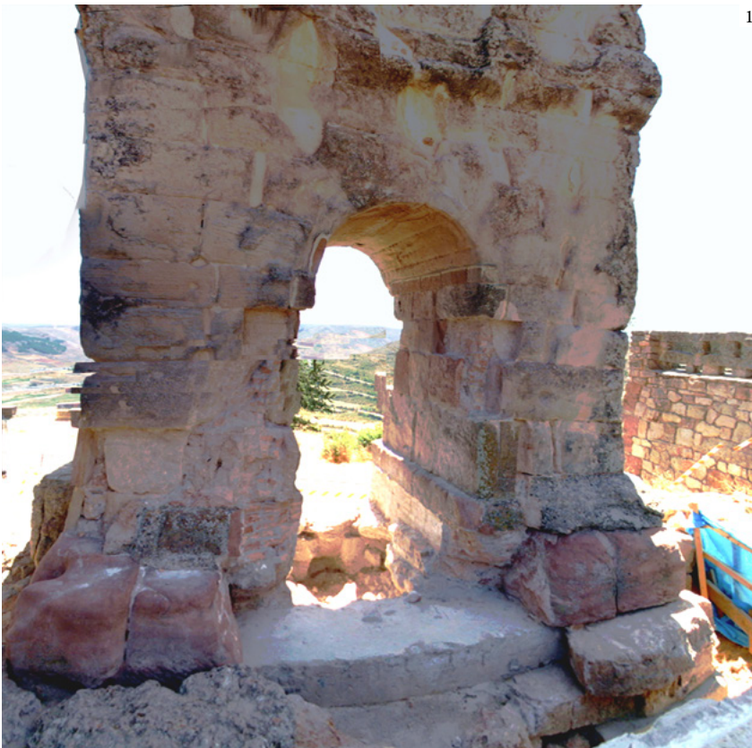
1: The western minor arch after emptying the soil fillings, showing the partial loss of its foundation 2: Western pilaster once propped, with an opus caementicium platform under the recovered base, awaiting the replacement of the sandstone orthostates | 1: El arco menor occidental tras el vaciado de los rellenos, mostrando la desaparición parcial de la cimentación 2: Pilastra occidental apeada, con plataforma de opus caementicium bajo el basamento recuperada, esperando la reposición de los ortostratos de arenisca | 1: O arco menor ocidental após o esvaziamento dos enchimentos, a mostrar a ausência parcial das fundações 2: Pilastra ocidental sustentada, com plataforma de opus caementicium por baixo do embasamento recuperado, à espera da reposição dos ortóstatos de arenito (1, 2: Junta de Castilla y León. José María Rincón)
