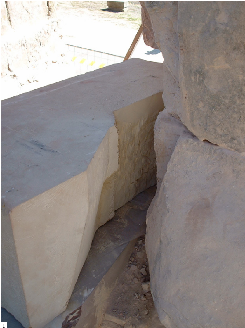
1: New ashlar prepared to adjust the templates of the lateral joint and the extrados 2: Replacement of one of the cornice stone slabs 3: Adjusting the templates of the joint between an original part and its graft | 1: Sillar nuevo preparado para ajustar las plantillas de la junta lateral y el trasdós 2: Reposición de una de las losas de la cornisa 3: Ajuste del aplantillado de la junta entre una pieza original y su injerto | 1: Silhar novo preparado para adaptar-se ao modelo da junta lateral e tardo 2: Reposição de uma das lajetas da cornija 3: Ajuste do modelo da junta entre a peça original e o enxerto (1and 3: Rodrigo de la Torre 2: Artelán restauración, S.L.)
