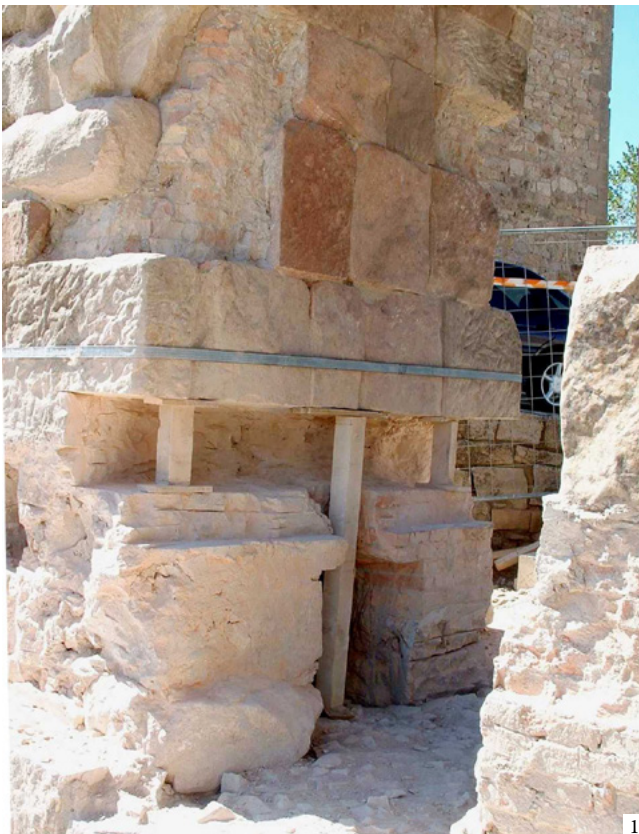
1: Detail of the western arch jamb during the demolition process of the brick filling and sandstone veneer 2 and 3: Details of the loss of material in the interior joints of the Arch's masonry | 1: Detalle de jamba del arco occidental durante el proceso de demolición del macizado de ladrillo y chapado de arenisca 2 y 3: Detalles de la pérdida de material en los planos de las juntas interiores de la fábrica del Arco | 1: Pormenor da jamba do arco ocidental durante o processo de demolição do maciço de tijolo e revestimento em pedra de arenito 2 e 3: Pormenores da perda de material nas zonas das juntas interiores da alvenaria do Arco (1, 2 and 3: Rodrigo de la Torre)
