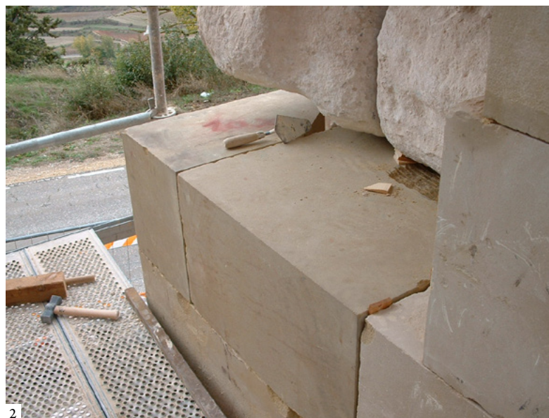
1: Partial view of the stonework workshop on site 2: Detail of the replacement of ashlar in the western arch | 1: Aspecto parcial del taller de cantería a pie de obra 2: Detalle de la reposición de sillares en el arco occidental | 1: Aspecto parcial do atelier de cantarias no local da obra 2: Pormenor da reposição dos silhares no arco occidental (1: Junta de Castilla y León. José María Rincón 2: Rodrigo de la Torre)
