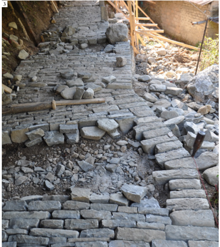
1: Handmade timber scaffolding for the dry-stone retaining wall 2: Layout of the two different types of the cobbled pathway 3: Works in progress | 1: Andamio de madera hecho a mano para el muro de contención de piedra seca 2: Composición de los dos tipos diferentes de camino empedrado 3: Obras en curso | 1: Andaime em madeira feito a mão para o muro de contenção de pedra solta 2: Composição dos dois tipos diferentes de caminho empedrado 3: Obras em curso (1: Anna Lagaria 2: Grigoris Koutropoulos, BLK 3: Pietro Radin, George Zoilis)
