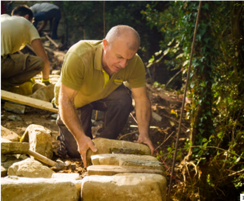
1: Laying the cornerstones of the pathway 2: Demonstration of traditional stone carving techniques by a senior stone mason, Giorgos Pappas | 1: Colocación de las piedras del camino 2: Enseñanza de las técnicas tradicionales de tallado en piedra por el maestro cantero Giorgos Pappas | 1: Colocação das pedras no caminho 2: Ensino das técnicas tradicionais de esculpir em pedra pelo mestre canteiro Giorgos Pappas (1, 2: Pietro Radin, George Zoilis)
