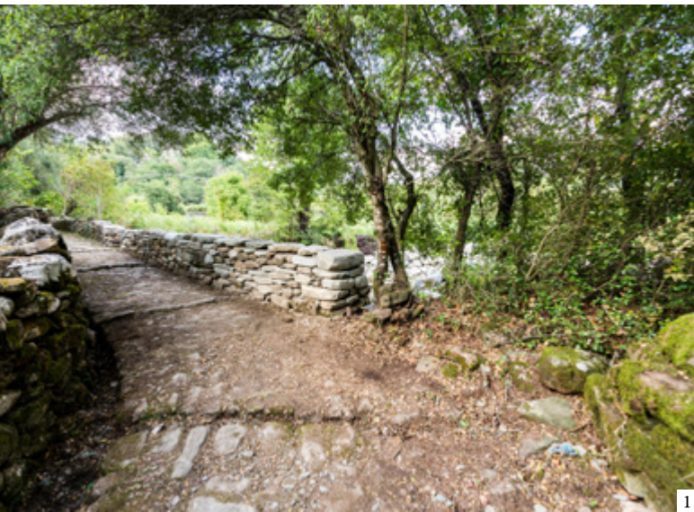
1: Part of the restored dry-stone wall 2: Dry-stone wall rebuilt in order to allow the tree growth | 1: Parte del muro de piedra seca restaurado 2: Muro de piedra seca reconstruido para permitir el crecimiento de los árboles | 1: Parte do muro em pedra solta restaurado 2: Muro de pedra solta reconstruido para permitir o crescimento das árvores (1: George Dimitrakopoulos 2: Ionas Sklavounos, BLK)
