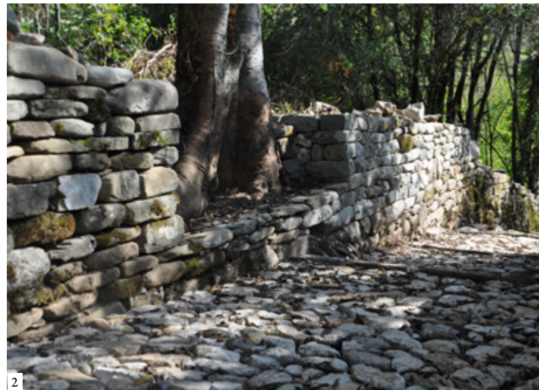
1: Part of the restored dry-stone wall 2: Dry-stone wall rebuilt in order to allow the tree growth | 1: Parte del muro de piedra seca restaurado 2: Muro de piedra seca reconstruido para permitir el crecimiento de los árboles | 1: Parte do muro em pedra solta restaurado 2: Muro de pedra solta reconstruido para permitir o crescimento das árvores (1: George Dimitrakopoulos 2: Ionas Sklavounos, BLK)
