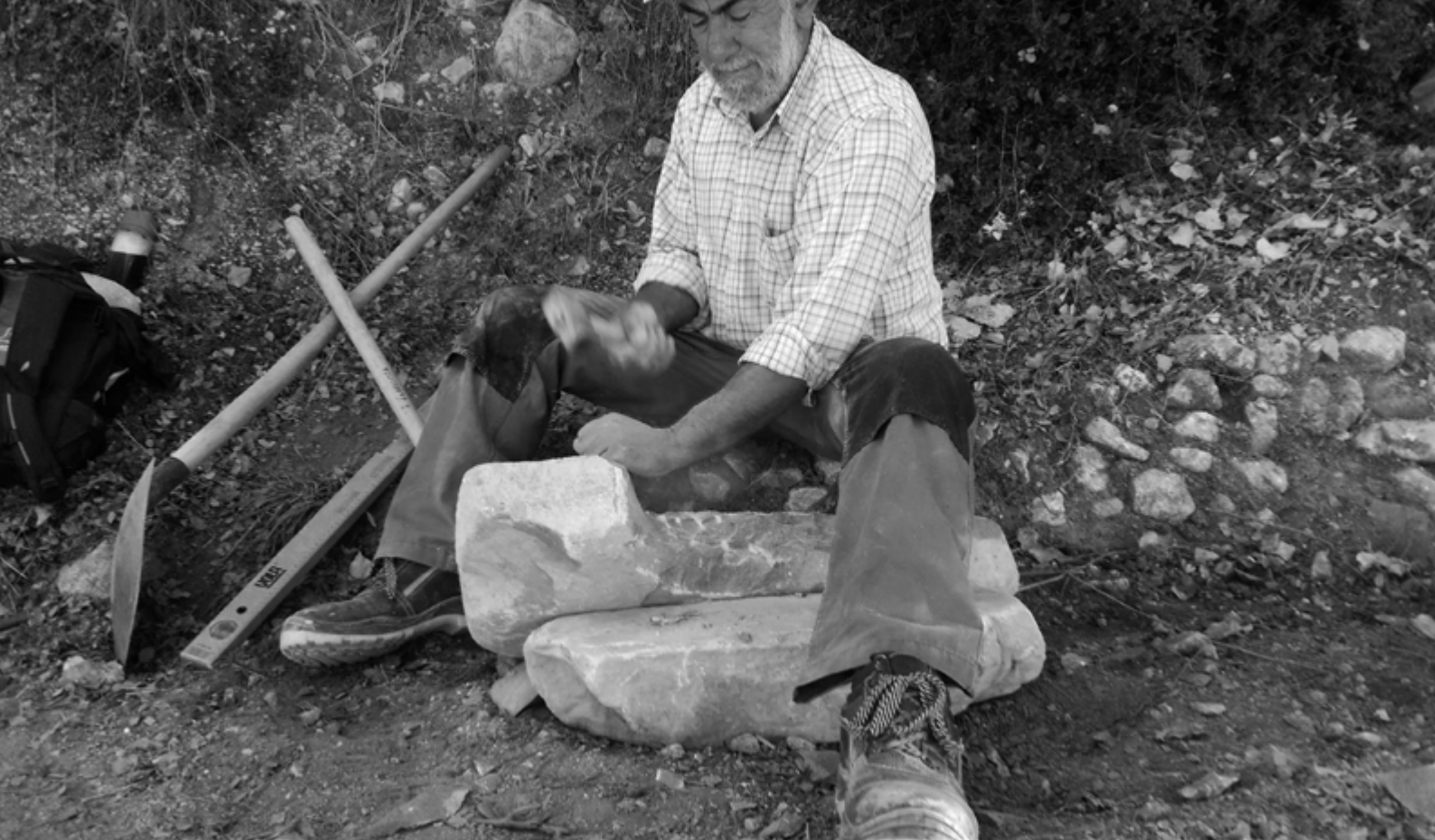
Carving an arkas , a type of traditional stone barrier | Tallado de arkas , un tipo de quitamiedos tradicional de piedra | Esculpido de arkas , um tipo de barreira protectora tradicional em pedra (Ionas Sklavounos, BLK)
