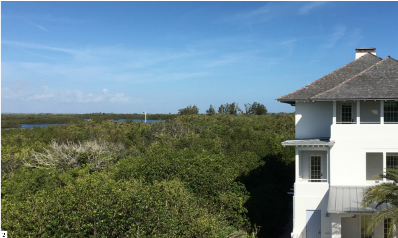
1: Site location plan. The site, previously undeveloped, is on the western edge of the barrier island and the eastern edge of an archipelago 2: View looking towards Pelican Island | 1: Plano de situação. El lugar, previamente sin desarrollar, se encuentra en el borde occidental de la isla y en el borde oriental de un archipiélago 2: Vista mirando hacia Pelican Island | 1: Plano de implantação. A zona, previamente sem desenvolver ainda, encontra-se no bordo ocidental da ilha e no bordo oriental de um arquipélago 2: Vista a olhar para o Pelican Island (1: MPCA 2: Scott Merrill)
