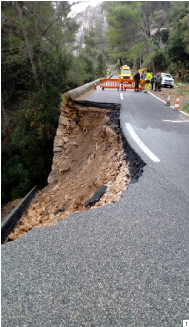
1 and 2: First reconstruction works on the wall that supported the collapsed road section | 1 y 2: Primeros trabajos de reconstrucción del muro que soportaba el tramo de carretera colapsado | 1 y 2: Primeiros trabalhos de reconstrução do muro que suportava o troço de estrada colapsada (1: Diario Última Hora 2: Rebeca Gómez-Gordo)
