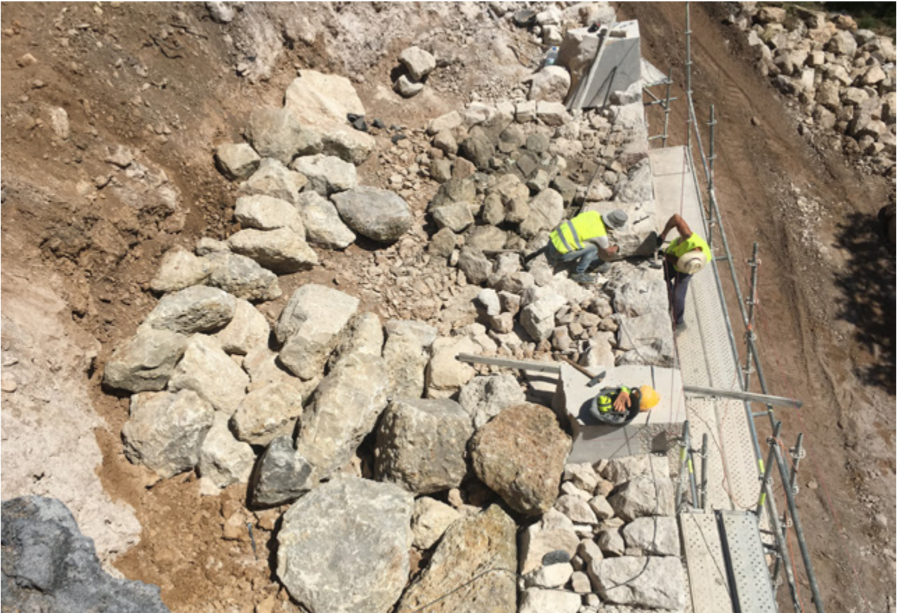
Master margers (dry-stone masters) placing the stones | Maestros margers colocando las piedras | Mestres margers (mestres da construção dos muros em pedra solta) a colocar as pedras
