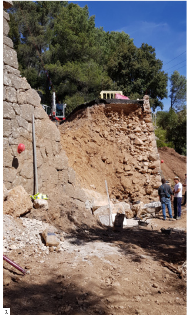
1 and 2: First reconstruction works on the wall that supported the collapsed road section | 1 y 2: Primeros trabajos de reconstrucción del muro que soportaba el tramo de carretera colapsado | 1 y 2: Primeiros trabalhos de reconstrução do muro que suportava o troço de estrada colapsada (1: Diario Última Hora 2: Rebeca Gómez-Gordo)
