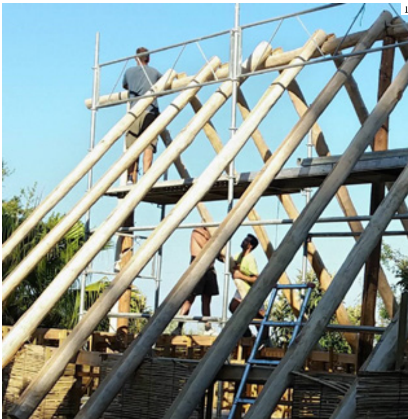
1: Assembling the ceiling with chestnut sticks 2: Construction of the openings 3: Preparation of the earth, straw and water mixture 4: Wattle walls | 1: Montaje del techo con palos de castaño 2: Formación de los huecos 3: Preparación de la mezcla de tierra, paja y agua 4: Cerramientos de cañizo | 1: Instalação do tecto com troncos de madeira de castanheiro 2: Formação dos vãos 3: Preparação da mistura de terra, palha e água 4: Envolvente de cañizo
