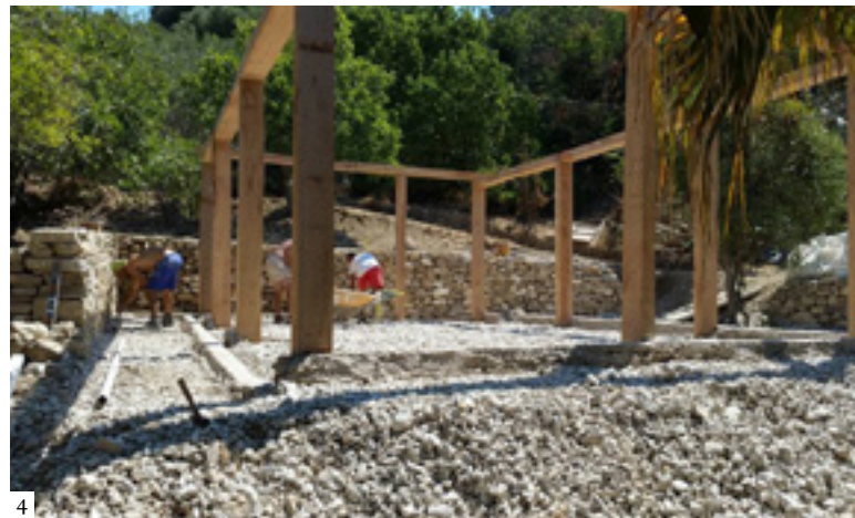
3: Construction of the lime floor 4: Slope formation and ground leveling | 3: Construcción de la solera de cal 4: Formación de pendiente y nivelación del terreno | 3: Construção da soleira em cal 4: Formação da pente e nivelamento do terreno
