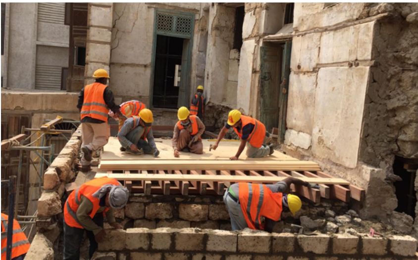
Traditional construction methods ( Turathiya ) | Técnicas de construcción tradicional ( Turathiya ) | Métodos tradicionais de construção ( Turathiya )
