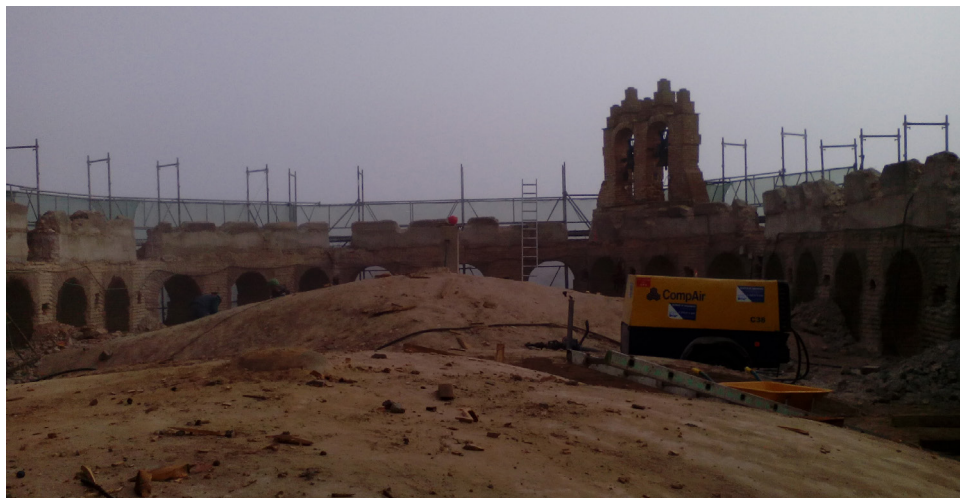
Fig. 8: Cubierta de la iglesia desmontada durante las obras. Fuente: Parroquia de Santa Catalina.
