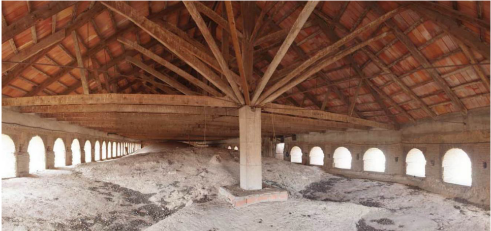
Fig. 6: Estado de la cubierta con anterioridad a la intervención. Fuente: Madrid Pinilla (2014: 12).
