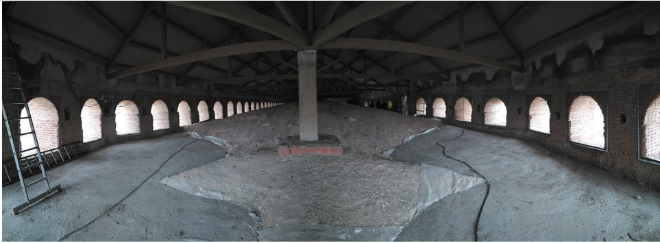
Fig. 9: Estado de la cubierta, una vez finalizada la restauración. Fuente: Parroquia de Santa Catalina.
