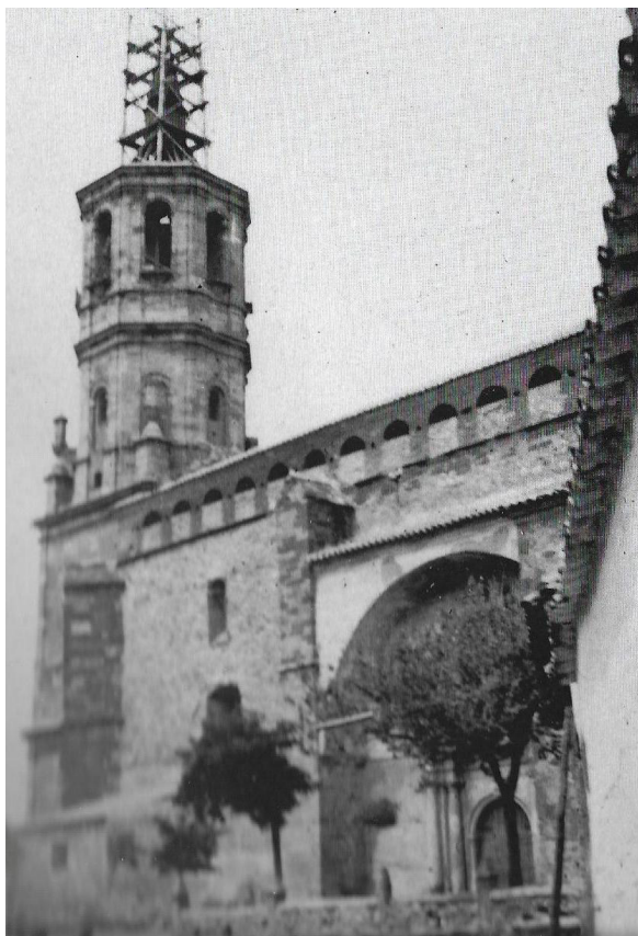
Fig. 4: Construcción del nuevo chapitel, en 1957. Fuente: García Cervigón (1997: 35).
