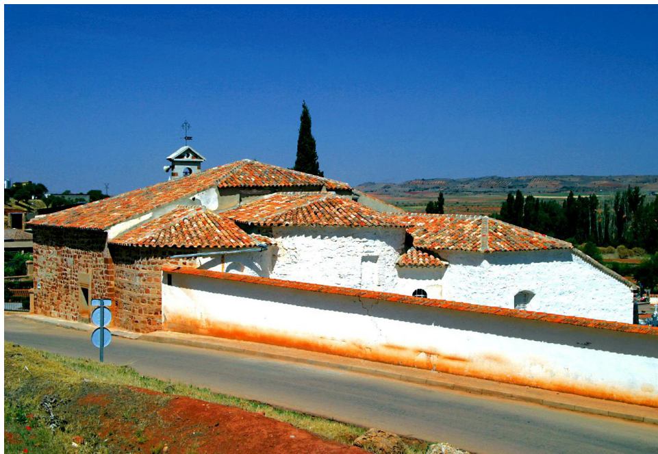
Fig. 3: Ermita del Santo Cristo de Montiel. Restos antigua vicaria de Santiago. Particularmente interesantes son las ventanillas bajo arco de herradura situadas exteriormente en el ábside semicircular perteneciente a la nave de la epístola.
